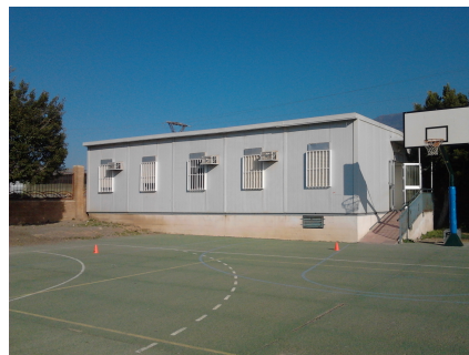
Fotos de las ocho aulas prefabricadas que tiene el IES Fuente Nueva
