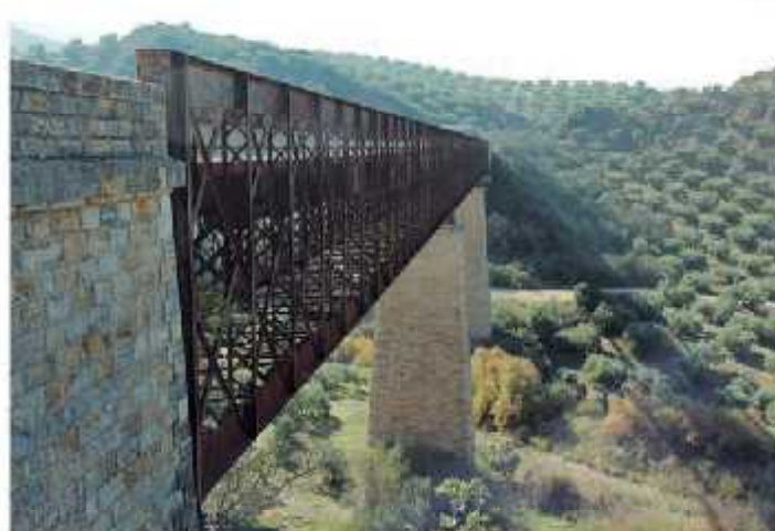
Viaducto del Arroyo Salado (1890) en Martos (Jaén).
