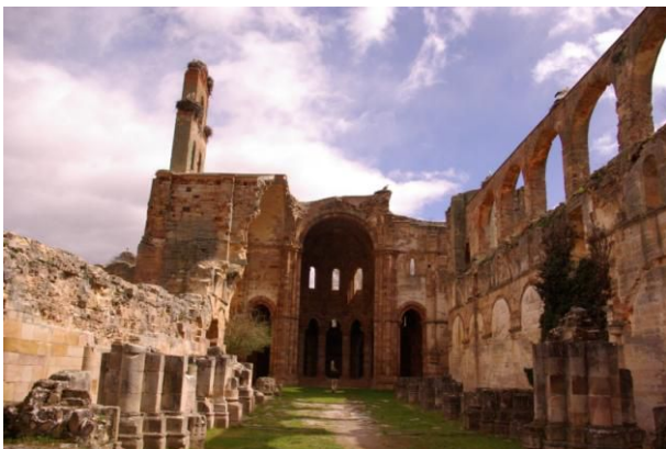
Doc. 12: Estado actual de edificio desarmortizado
