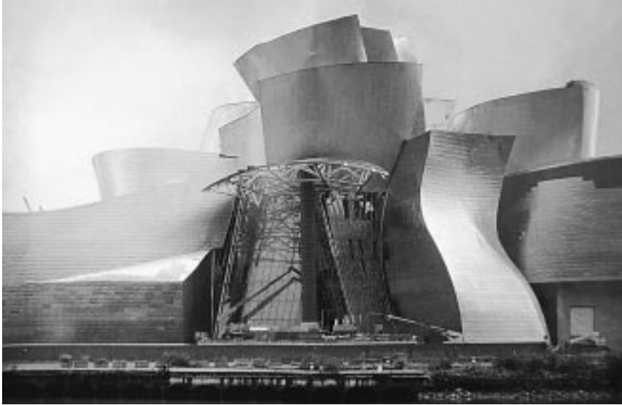
Museo Guggenheim, Bilbao. Frank Gehry, 1997 en fase de construcción.
