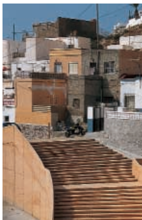
DETALLE DE LA REHABILITACIÓN DEL BARRIO DE LA CHANCA EN ALMERÍA.
