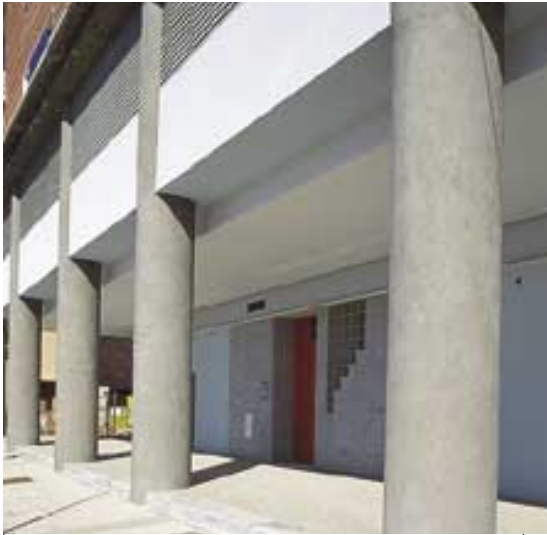
Detalle constructivo. PERI Zafra. Huelva.
