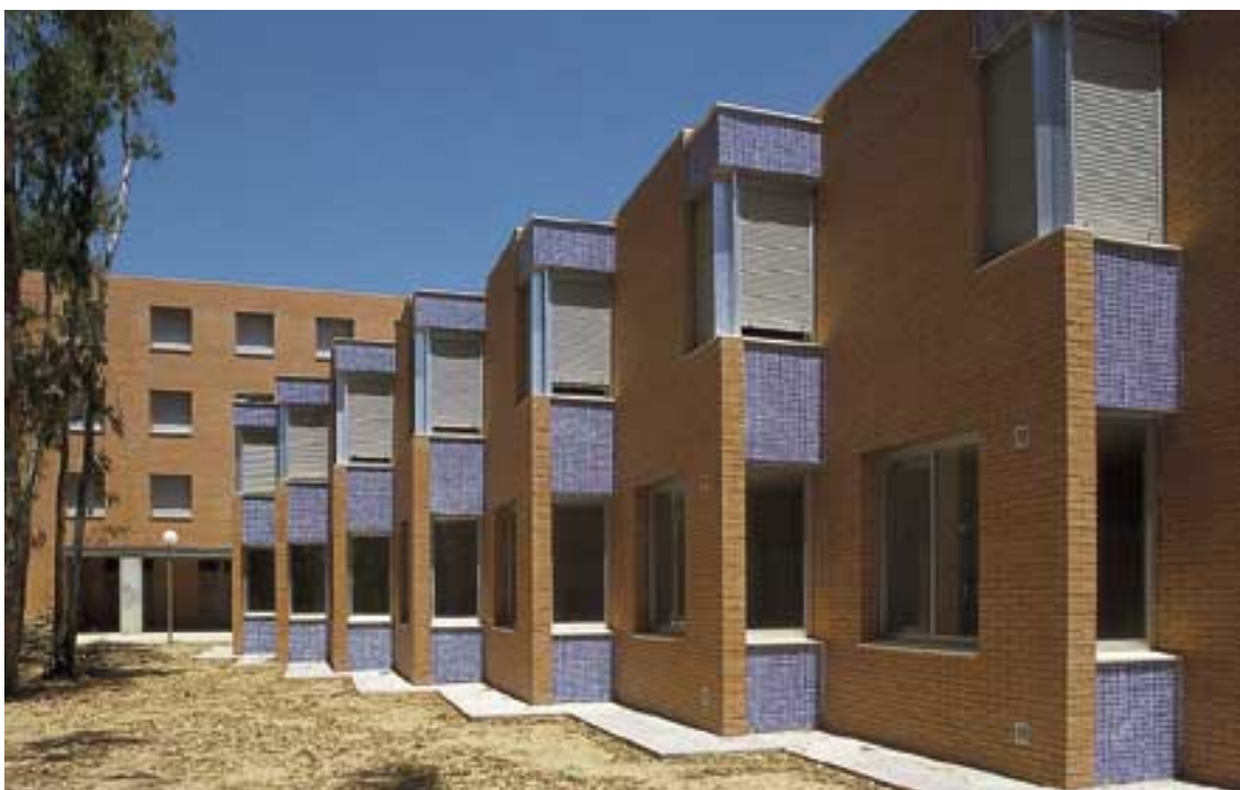
Viviendas en alquiler para universitarios, Rabanales. Córdoba.
