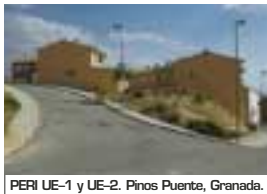
PERI UE-1 y UE-2. Pinos Puente, Granada.
