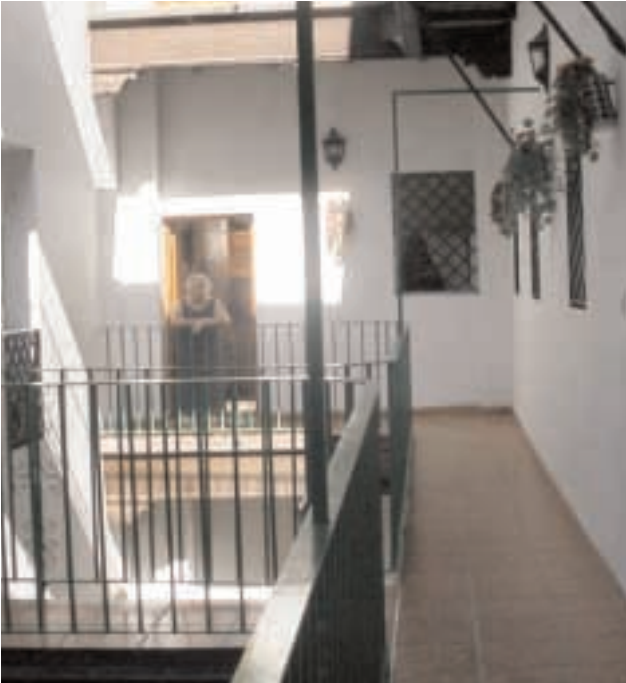
Rehabilitación en Casco Histórico de Cádiz. Calle Cardoso, 24 y Calle Suárez Salazar, 7-9.
