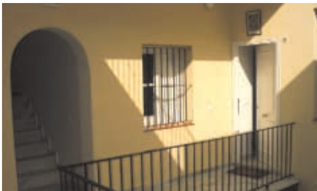
Interior de las viviendas rehabilitadas en la calle Suárez de Salazar, 7-9. Cádiz.
