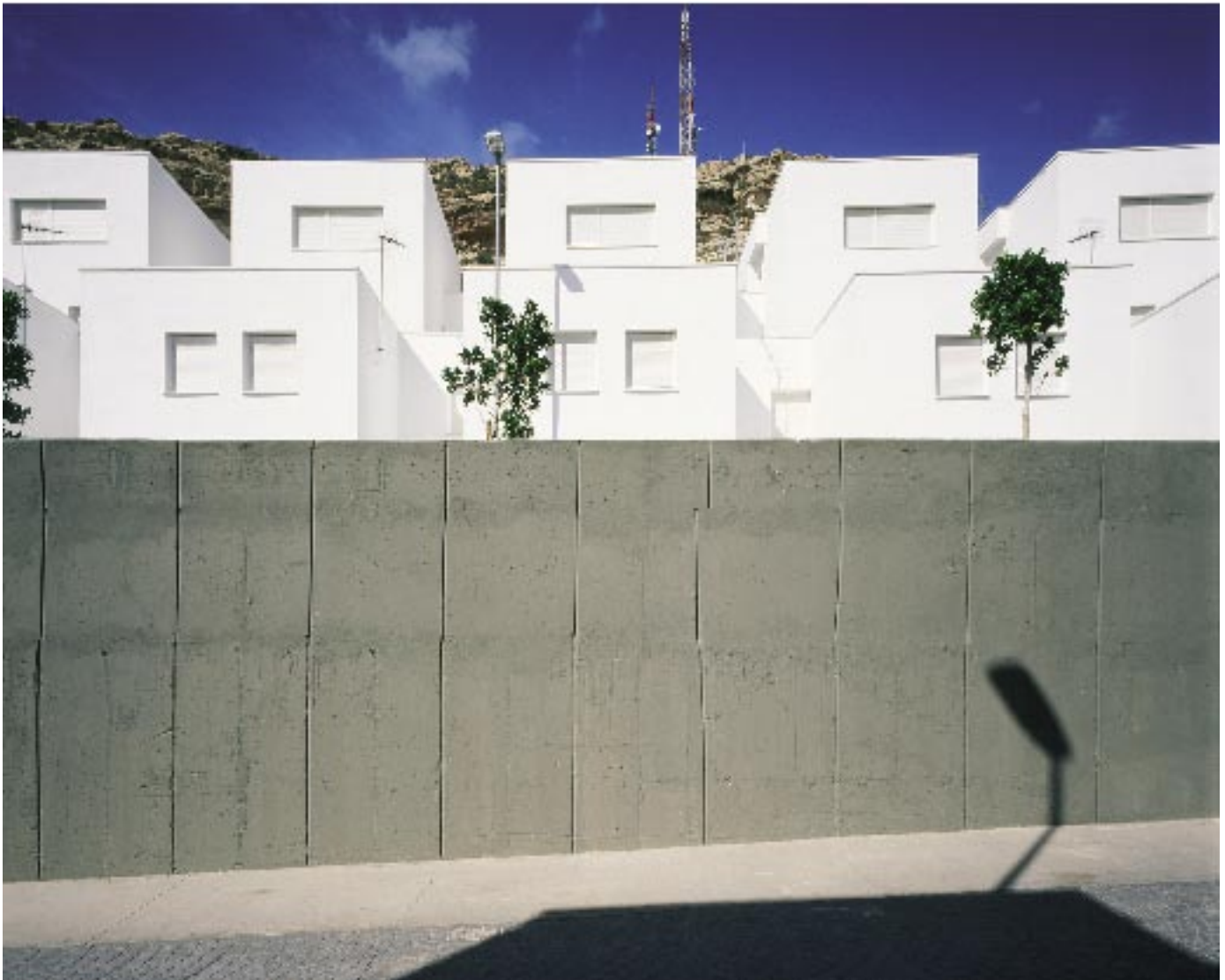
43 VPPC en calle Valdivia. La Chanca, Almería. Nicolás Cermeño Gines. Arquitecto
