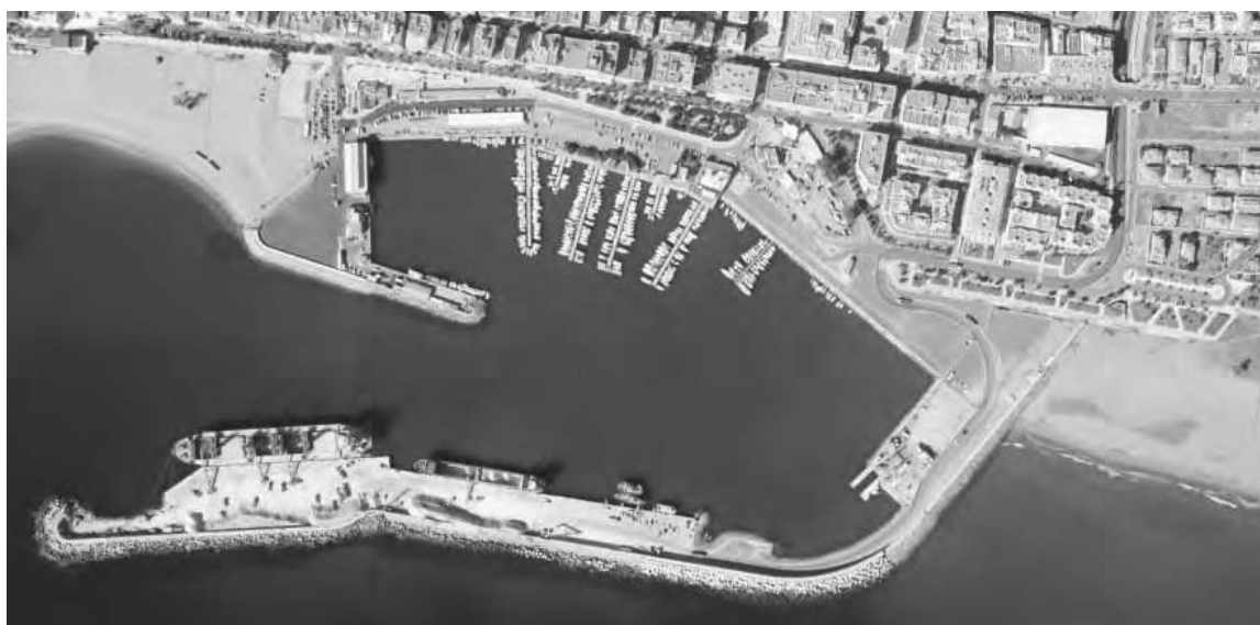
Situación actual de la zona de servicio
