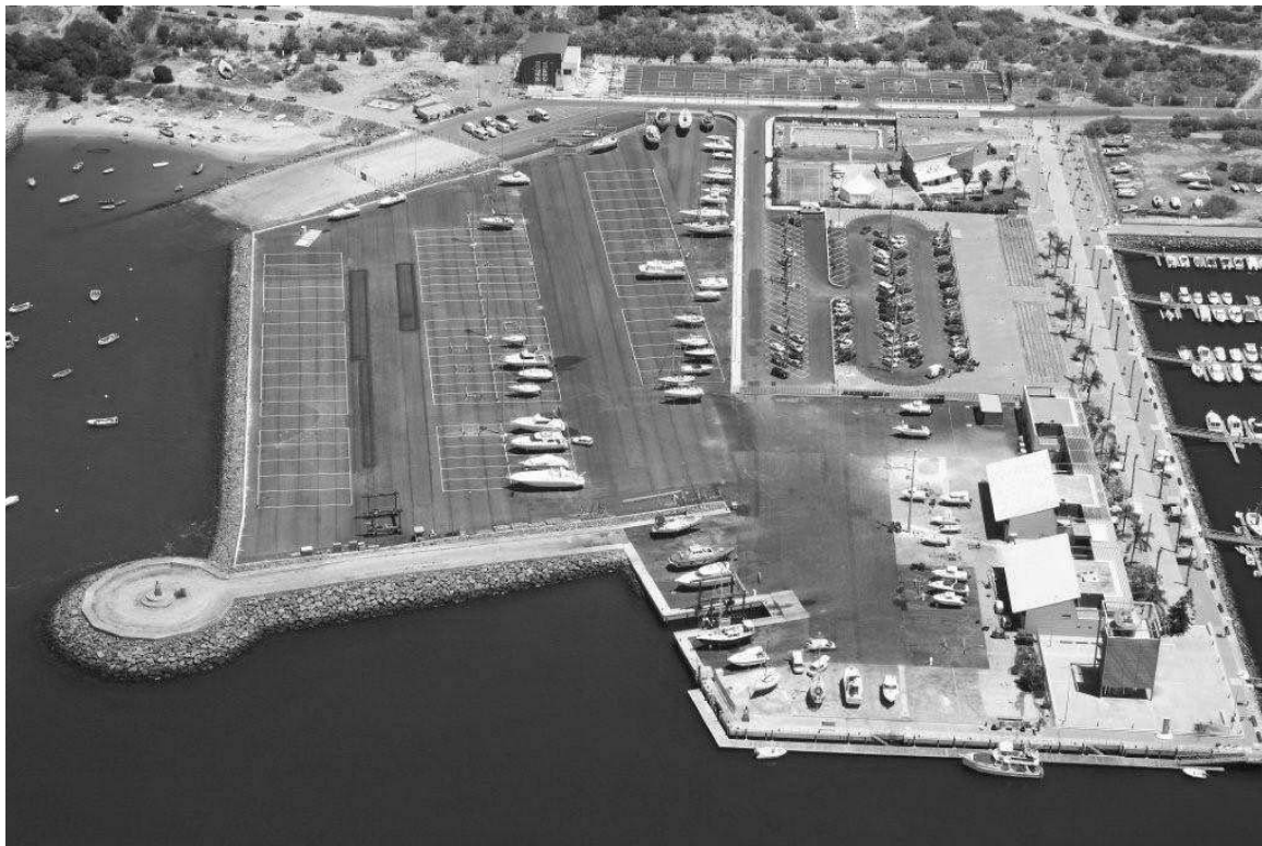
Vista general del nuevo varadero
