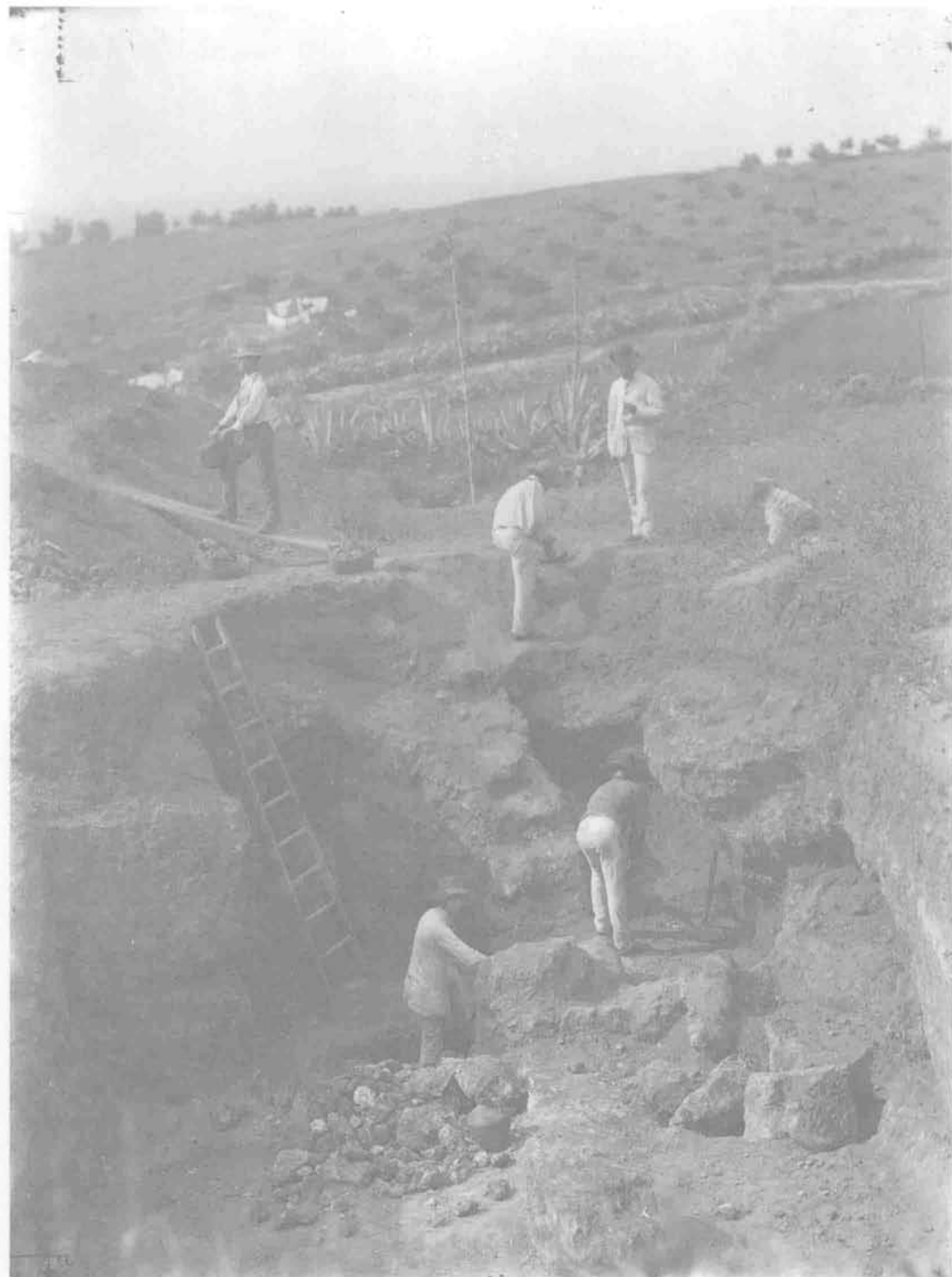
Trabajos de excavación.
