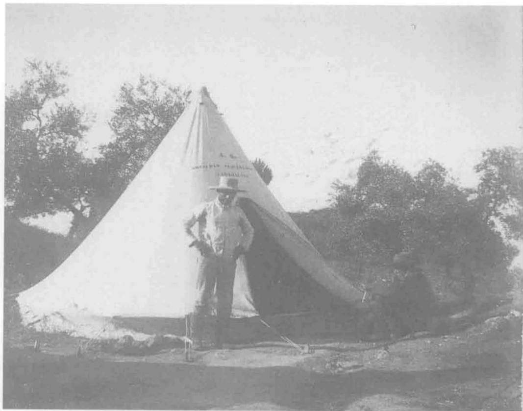
Tienda de campaña de la Sociedad Arqueológica Carmonense, utilizada para los trabajos de excavación.
