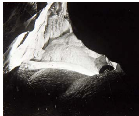
Instalación de iluminación. AHPH. Colección de Fotografías estereoscópicas, nº 504
