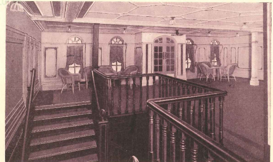
Escalera de Entrada al Salón de Baile
