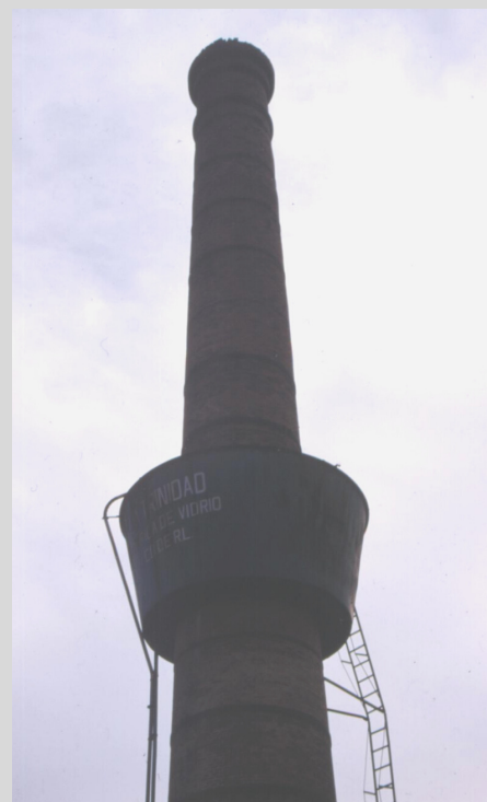
AHPSE. Fábrica de Vidrio La Trinidad, 26359
