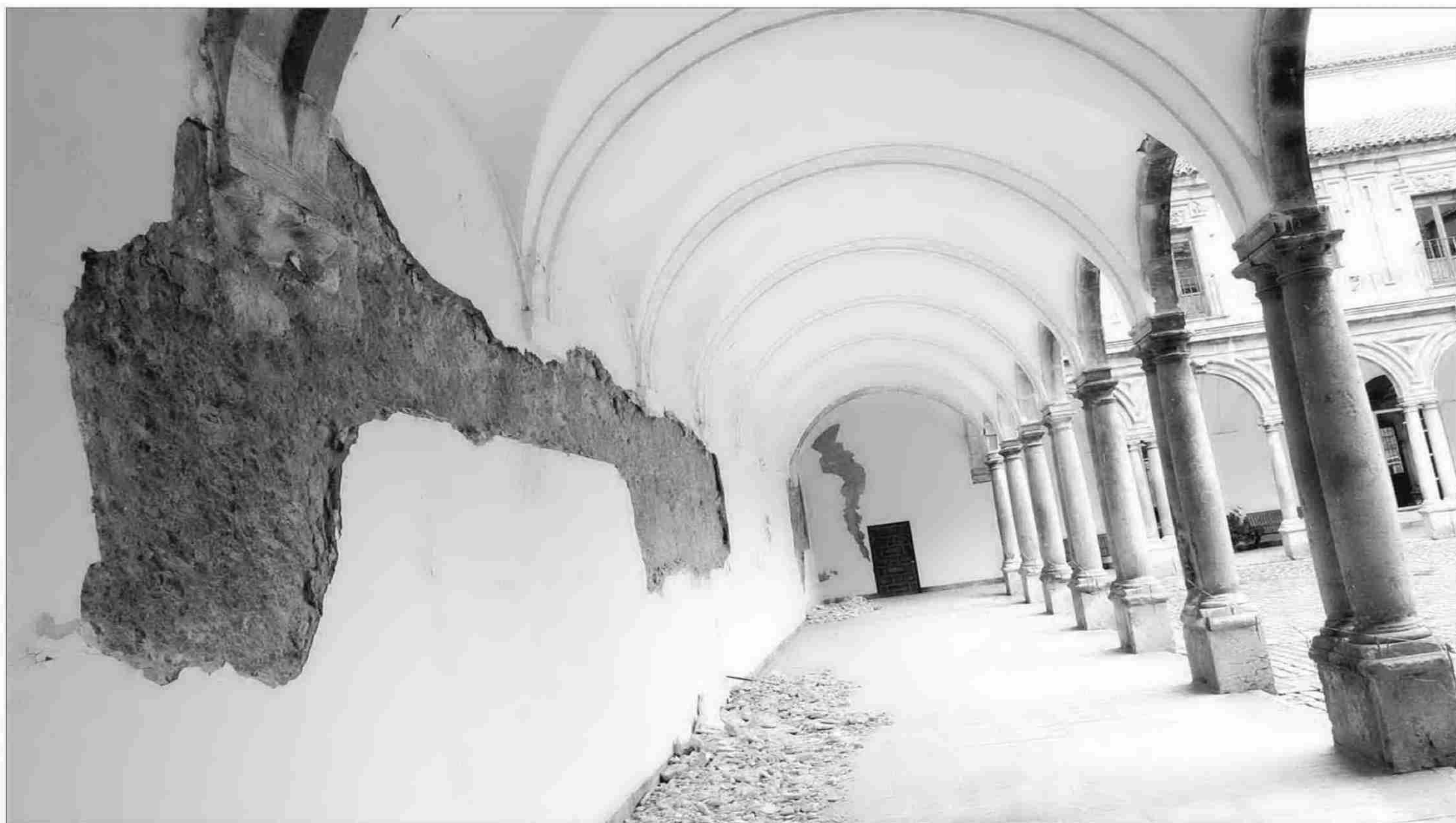
DESPRENDIMIENTOS. La galería paralela a la calle resulta la más afectada por las humedades, tal y como se aprecia en la imagen.
