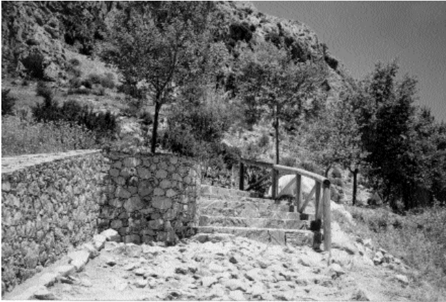
Lám. Vb. Acceso a la calzada después de terminar la obra civil de adecuación de 2001.
