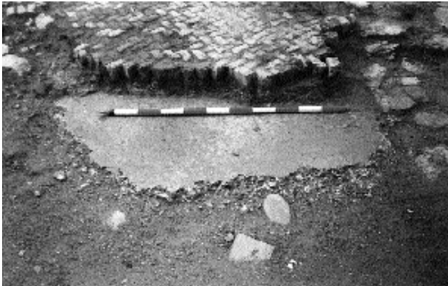
Lám. IV. Detalle del suelo de opus spicatum sobre el opus caementicium .
