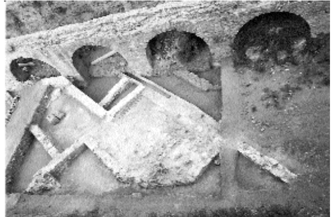
LÁMINA II. VISTA GENERAL SONDEOS 1, 8 Y 9
