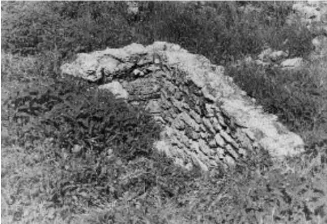
Figura 2. Pozo romano con boca rectangular acondicionada para la instalación de una rueda de pozo de tracción animal o noria. Actualmente rellena y soterrada (Parcela B). Fotografía de los años 70 cedida por la Asociación Cultural Caepionis (Chipiona).
