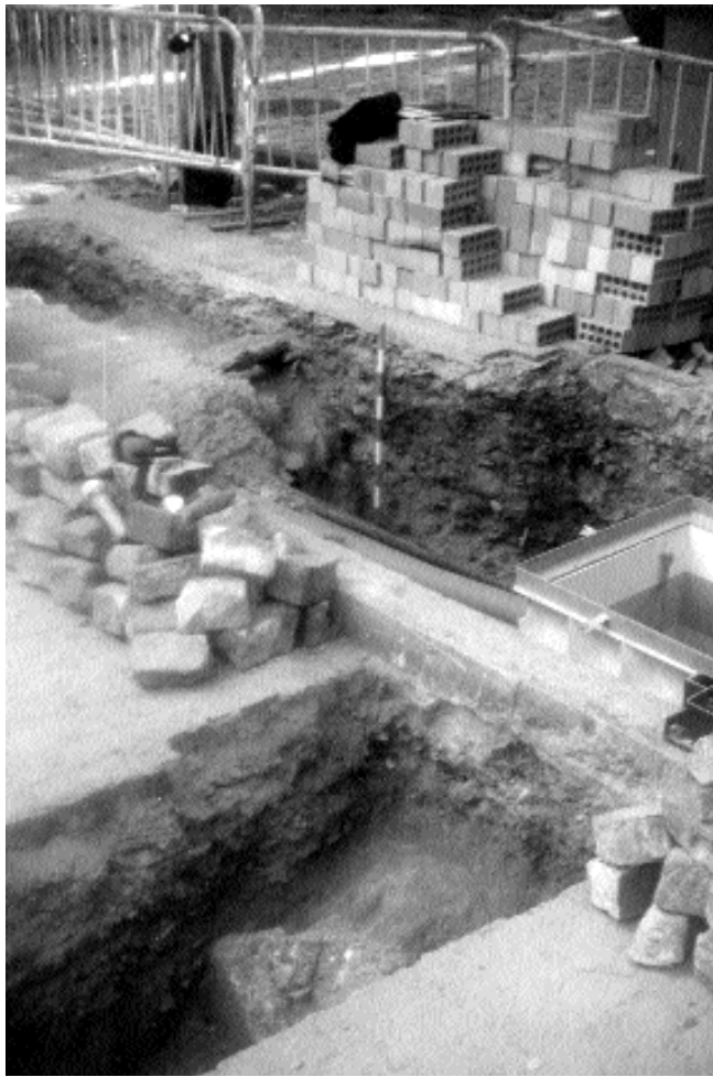
Lámina I. Vista general de la intervención.
