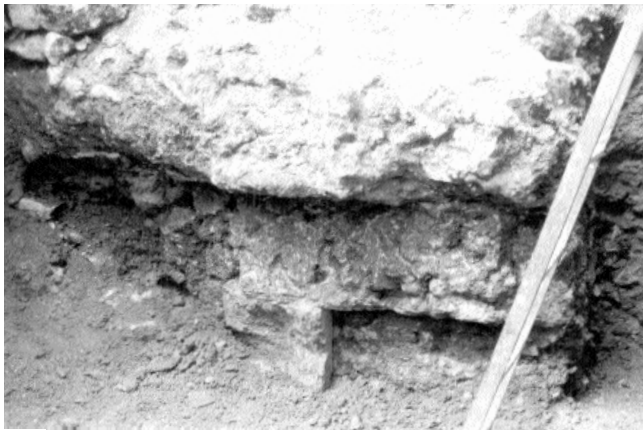
Lám. V. Escalonamiento invertido en la fábrica de caementicium documentado en el B-4, en el que se hallaron restos de un sillar incrustados en la misma.
