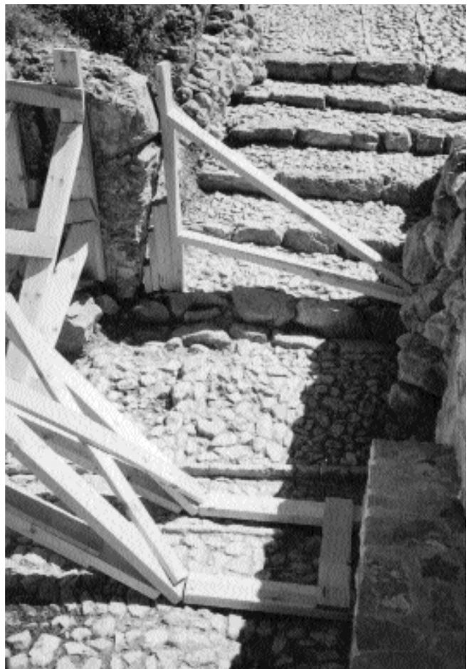
LÁM. IV: Apeo de paramentos verticales con puntales, crucetas, tirantes y muros de contención de piedra seca.
