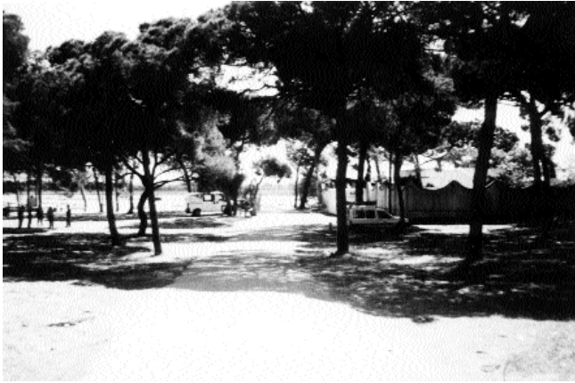
Lám. I: Vista general de la parcela antes de iniciar los trabajos de construcción de la nueva sede social de la Asociación Náutica Pesquera de Punta Umbría (Huelva).
