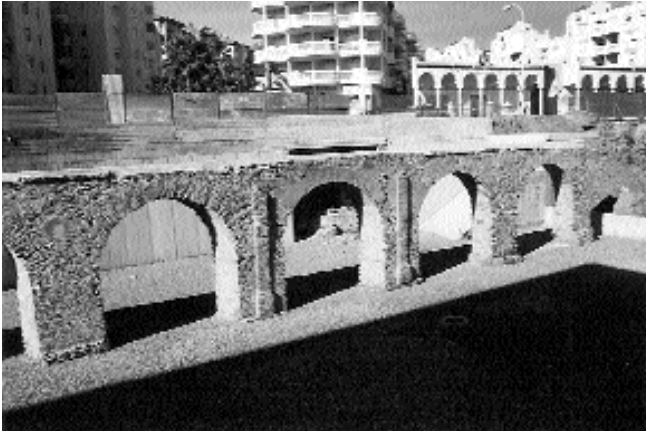
LÁMINA I. VISTA GENERAL DEL ACUEDUCTO
