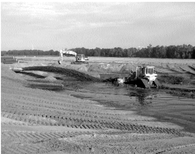
Fig 2 . Labores de decantación.
