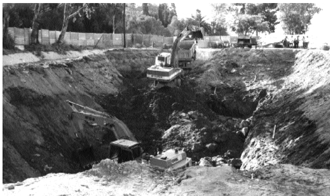
Figura 10. Extracciones en las obras de la Casa de Bombas.
