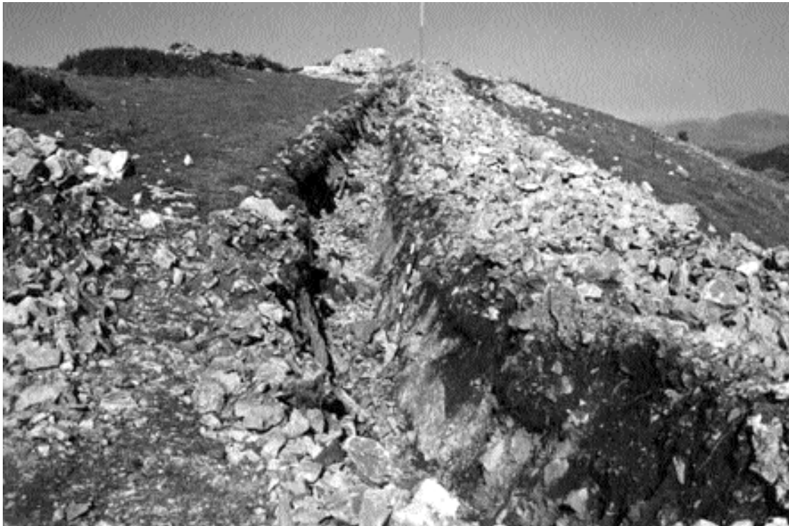
Lám. III. Zanja del tendido de media tensión entre el A6 y el A7.
