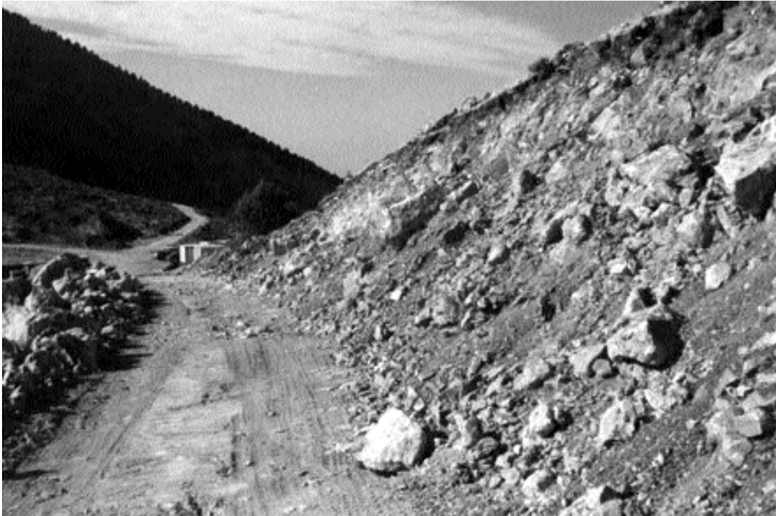
Lám. I. Pista de nueva construcción hacia el sector N.
