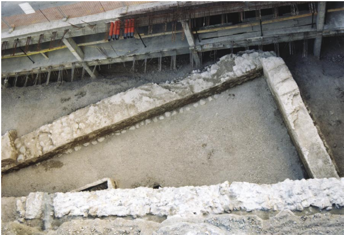
LAM. VII. Estructuras hidráulicas en el cauce de la Rambla de Belén.
