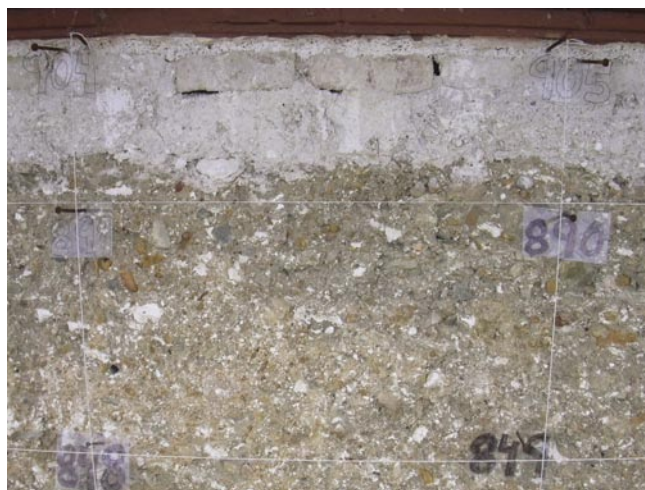
LAM. III. Detalle de los cajones de tapial en los Sectores 2 y 3.
