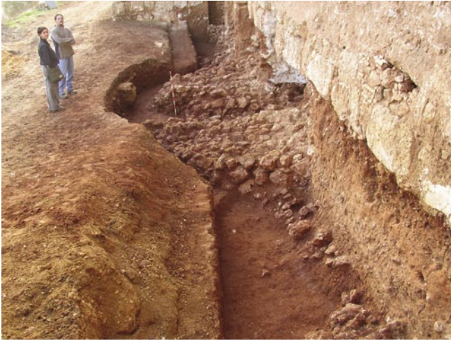
LÁM. I. Vista del bastión preferencio localizado en el Tramo 22-23.
