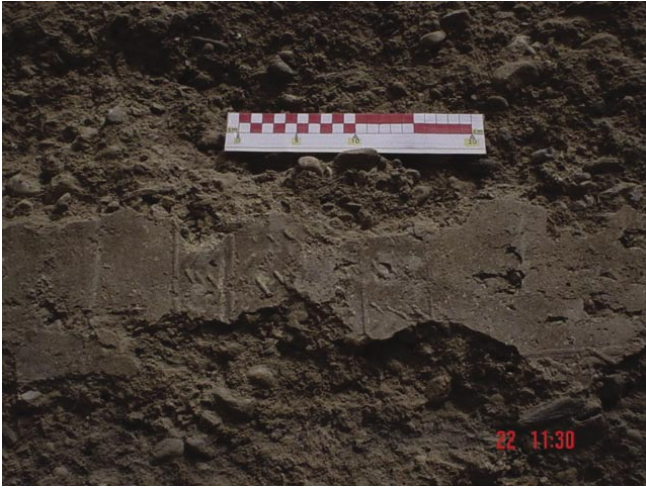
LAM. 4. Detalle del enfoscado que conserva en su superficie la impronta de los tablonos.
