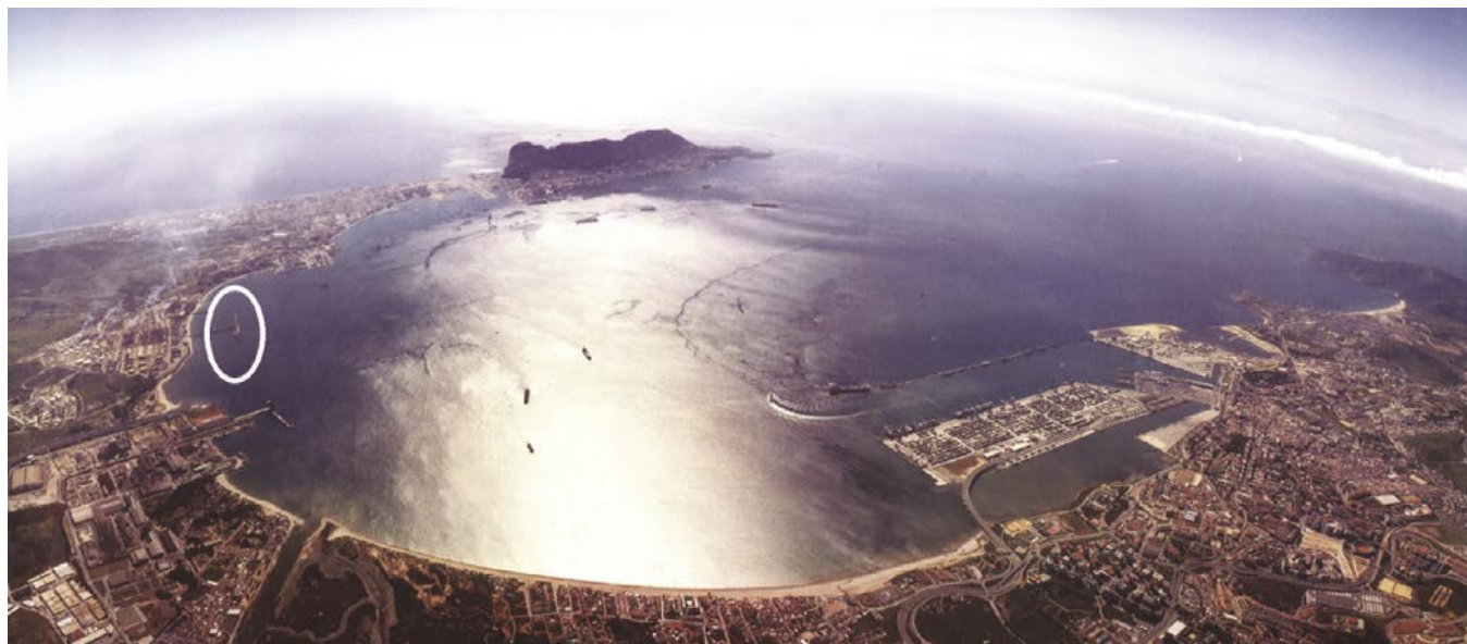
LÁM. I: Ubicación del área de ampliación del Pantalán de la Refinería "Gibraltar" en la Bahía de Algeciras (Fotografía: FISA, Escudo de Oro, S.A., Ediciones Pajares)
