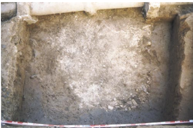
LÁM. V. Vista en planta de la fosa de drenaje.
