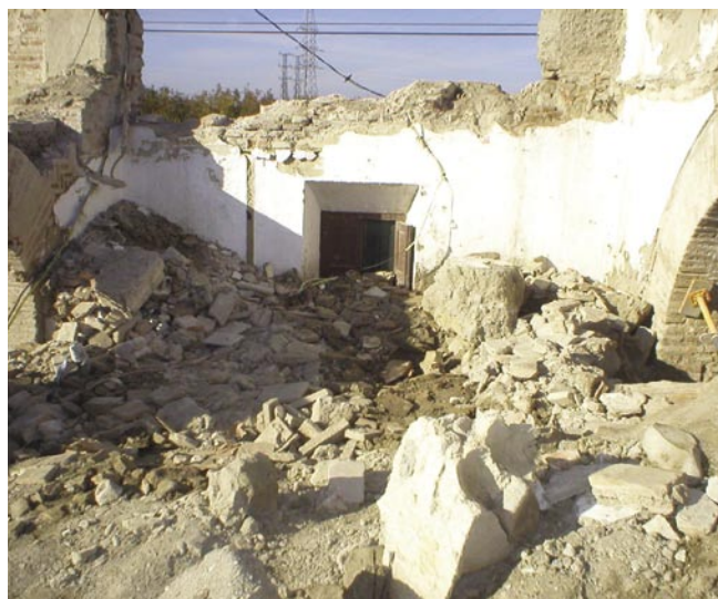
LAM. 2. Estado del edificio antes de la intervención.
