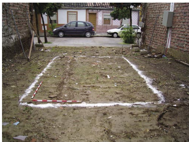
LÁM. II. Vista del solar y planteamiento del sondeo.
