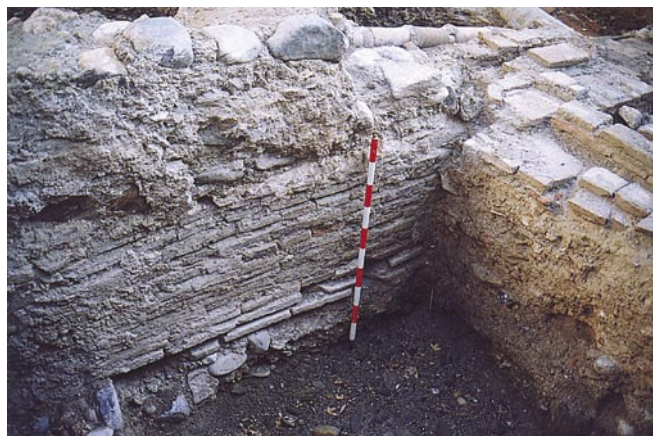
LÁM. III. Muro (M7) de ladrillo y tapial.
