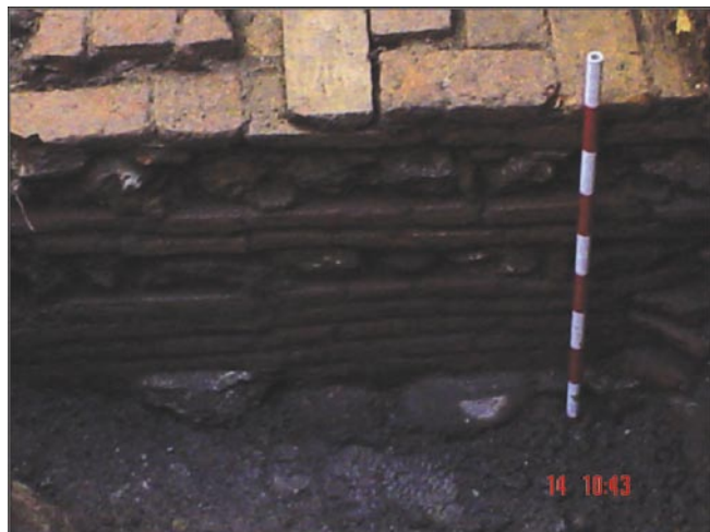
LÁM. I. Detalle de la cimentación y el alzado de la E-005.
