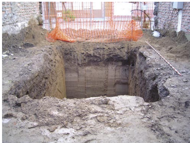
LÁM. III. Vista general del solar una vez finalizada la excavación.
