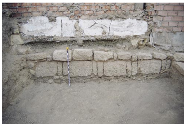
LÁM. III. Muro de sillarejos dispuestos a sogá y tizón.
