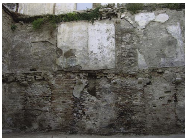
LAM. 2. Vista general después de la limpieza. Muro moderno.
