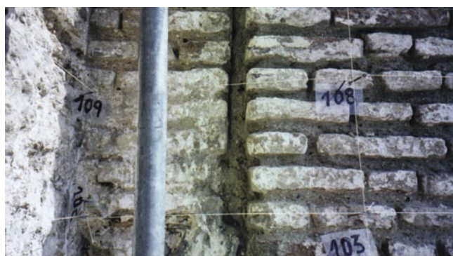
LAM. IV. Antiguo contrafuerte en el Sector 2.
