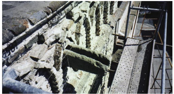
LAM. VI. Friso de arcos ojivales y desagüe tallado en piedra.
