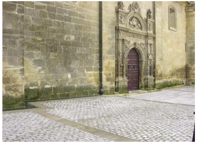
LÁM. 7. Estado actual de la Plaza de Padre Antonio.
