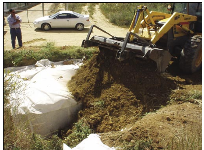
LAM. III. Retroexcavadora cubriendo la estructura.
