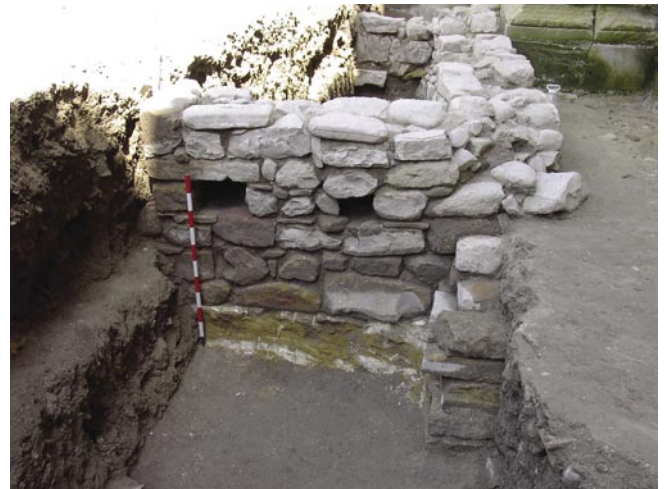
LÁM. 5. Huecos para recibir las vigas del forjado de la cantina. CE'2
