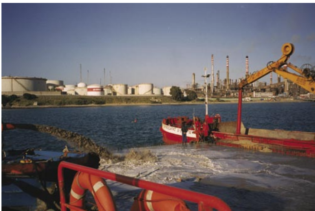
LÁM. VII: Descarga simultánea de las dos dragas a ambos lados del nuevo cajón.
