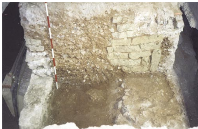
LÁM. 5. Perfil septentrional de la muralla de la Puerta Purchena, con un claro reforzamiento del exterior.
