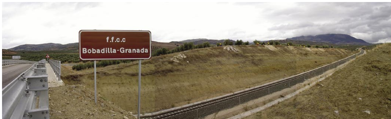
LAM. I. Vista general de la zona de intervención.
