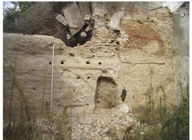
LAM. 7. Vista general del lienzo de muralla.
