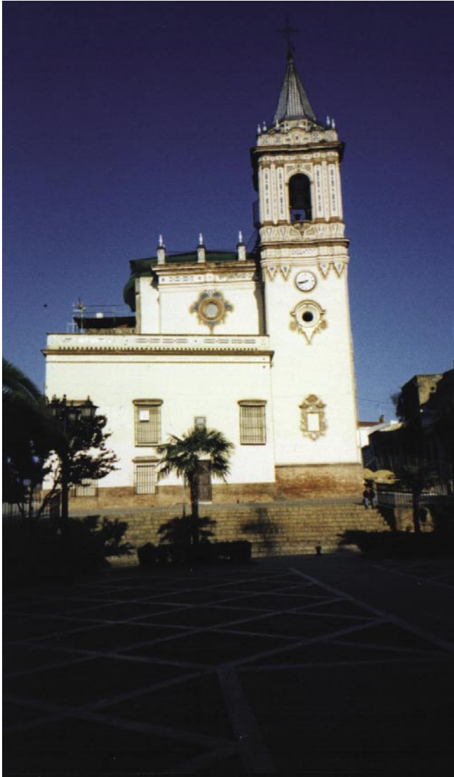
LAM. I. Panorámica de la actual cabecera de la iglesia de San Pedro (Huelva).
