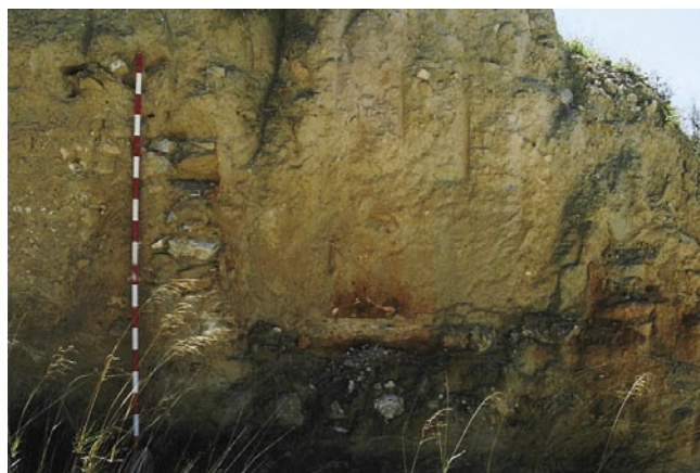
FOTO 4. Estructuras rotas por taludes calles.
