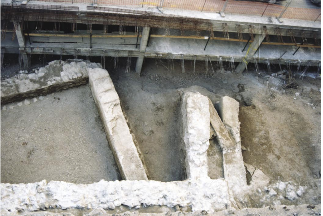
LAM. VIII. Estructuras hidráulicas en el cauce de la Rambla de Belén.
