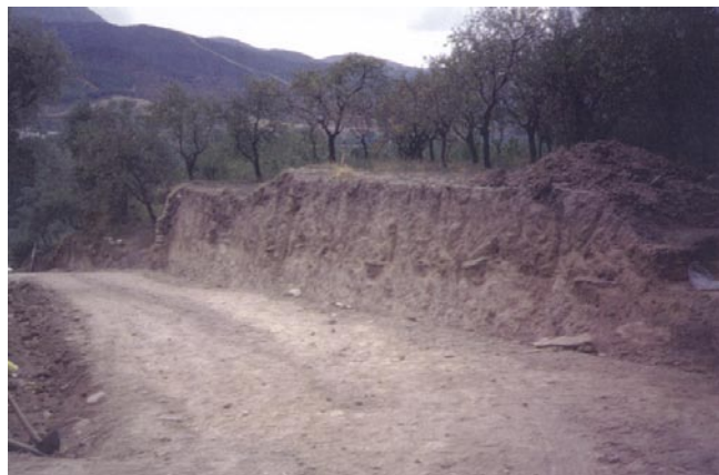
LÁM. 2. El perfil occidental excavado en las obras.
