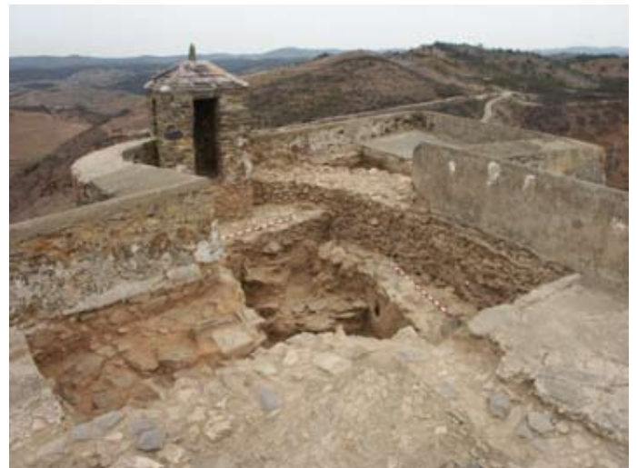
Lámina IV. Excavación de la torre-baluarte Noreste.
