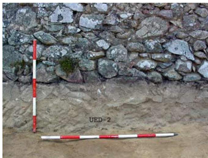
Lámina IV. Unidad de Intervención. Detalle de la cimentación
