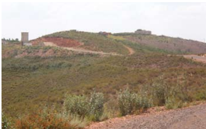
Vista general desde el camino de la futura situación del aerogenerador 3
