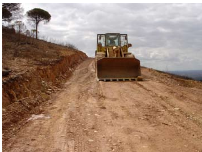
Camino de acceso a los aerogeneradores 1 y 2
