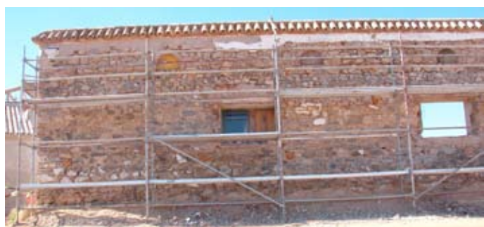
Lámina I. Detalle de las fábricas de muro E una vez retirados los enfoscados.
