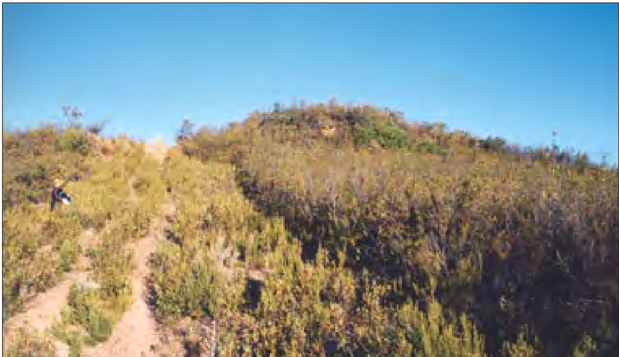
Fig. 4.8. Vista de la entrada Este al recinto RE con los bastiones antes de la limpieza.
