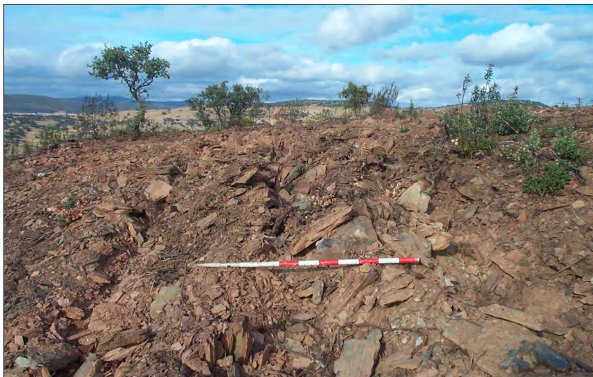
Fig. 4.3. Situación del recinto Oriental de La Papúa tras la destrucción producida por la reforestación.
