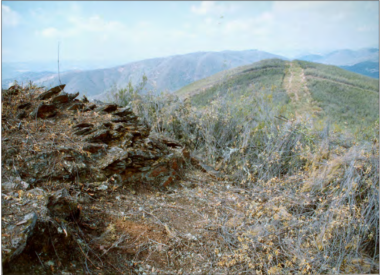
Fig. 4.11. Muro que delimita RE por el Oeste, al fondo el recinto RO.
