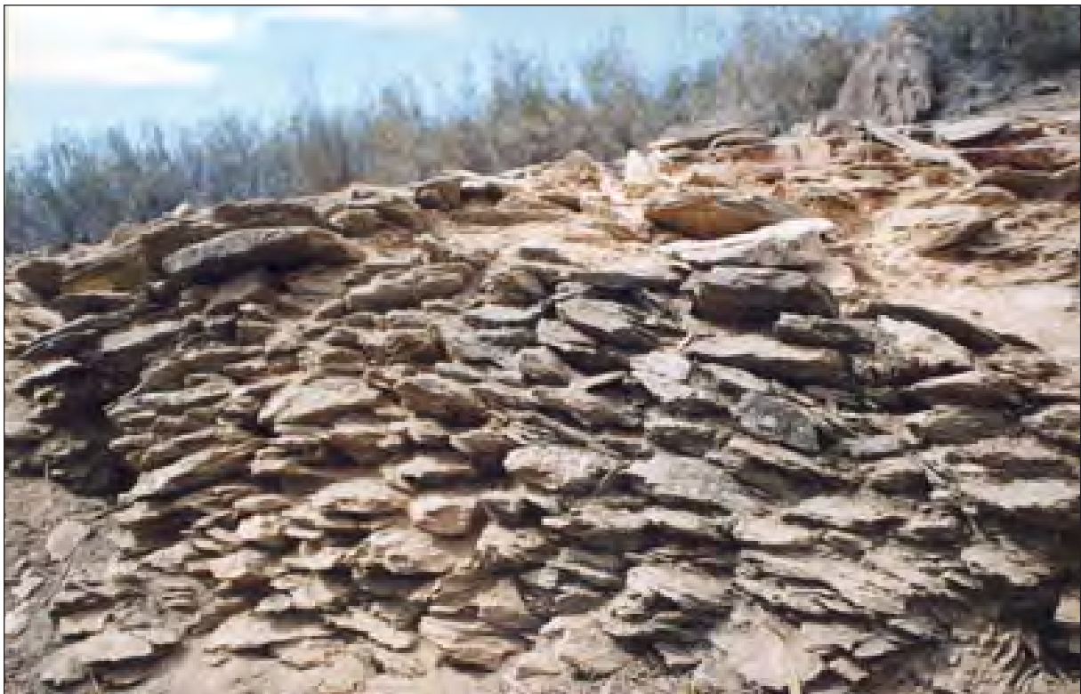
Fig. 4.23. Pared Este del muro en el corte C4.
