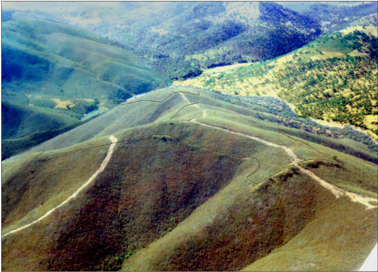
Fig. 4.7. Vista aérea de La Papúa desde el SE con la señalización de la muralla. Se observa a la derecha la entrada Este del recinto RE.
