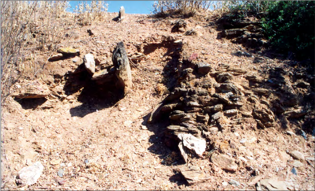
Fig. 2.33. Sistema de construcción del talud con la alternancia de grandes lajas en vertical.
