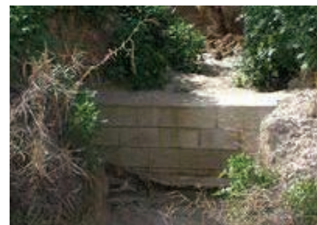
muros de contención de piedras
