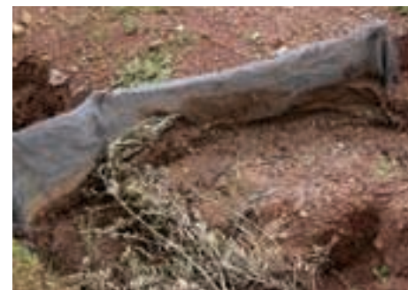
muros de contención de viguetas de hierro y malla
