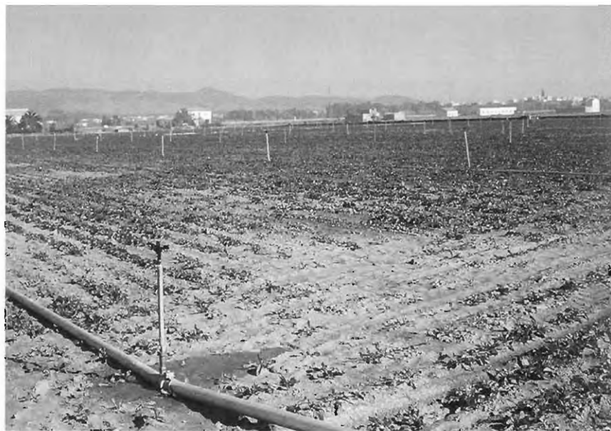
Figura 9. Red de tuberías en un riego por aspersión.
