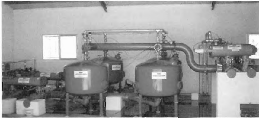
Figura 14. Cabezal de riego localizado.
