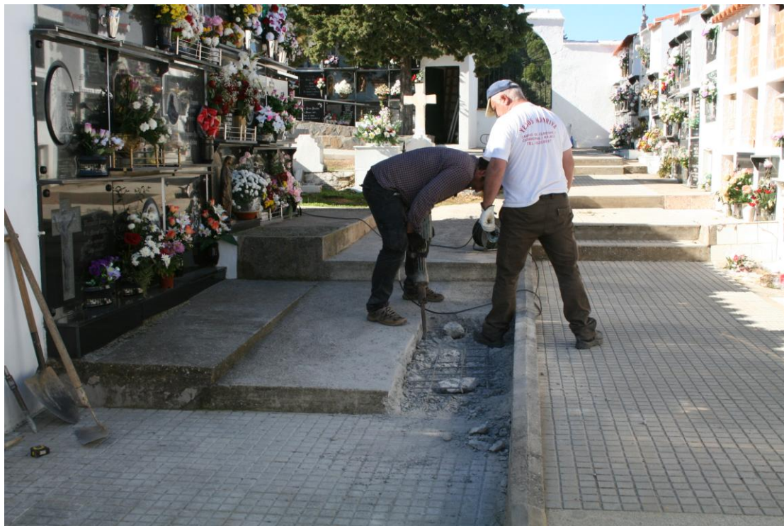
Trabajos en el sondeo 2
