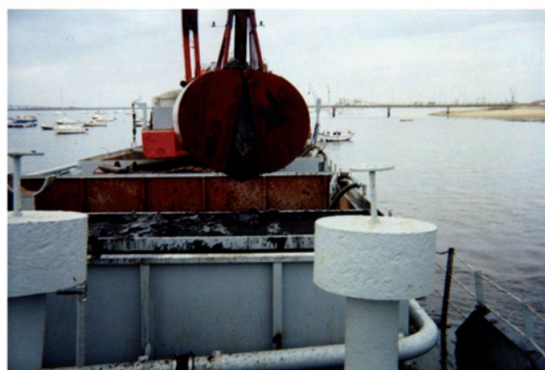
CARGA DE MATERIAL CON EXCAVADORA
