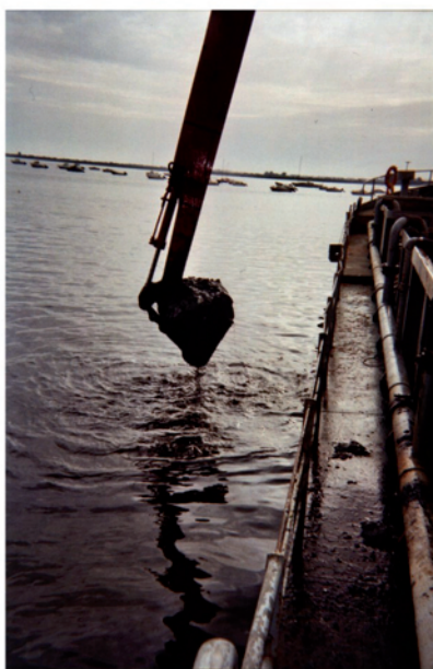
PROCESO DE DRAGADO CON EXCAVADORA
