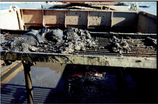
CÁNTARA Y REJILLA CON MATERIAL
