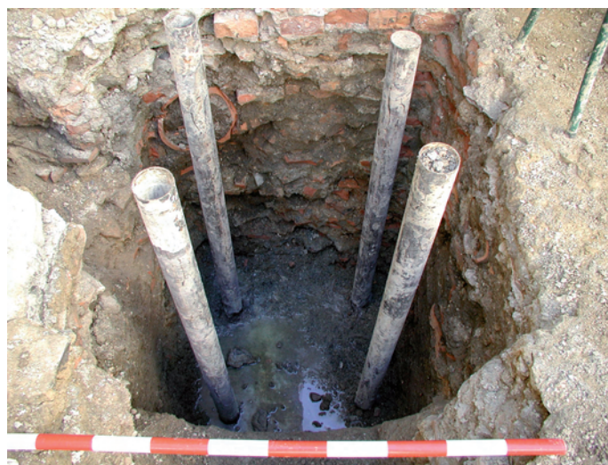
Lámina I. Excavación del pozo de arriostramiento. Perfil estratigráfico
