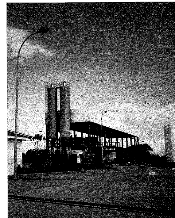
Planta de Tratamiento de Residuos Plásticos Agrícolas de los Palacios (Sevilla). P.O. Bajo Guadalquivir.
