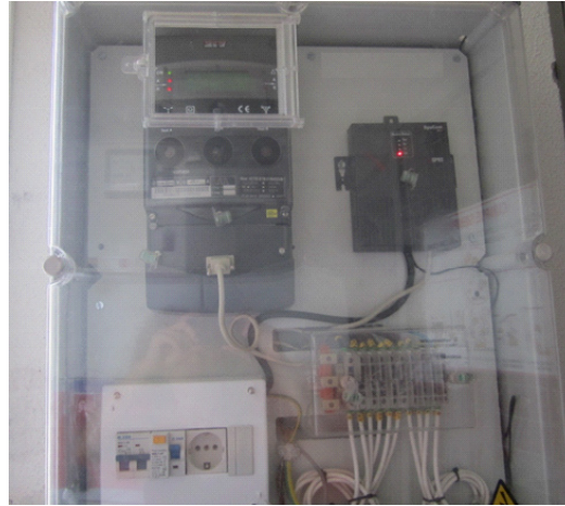
Figura 26: Medidor inteligente de fuerza (arriba a la izquierda) con sistema de transmisión radio de datos de medida (arriba a la derecha). Fuente: Fundación HABITEC.
