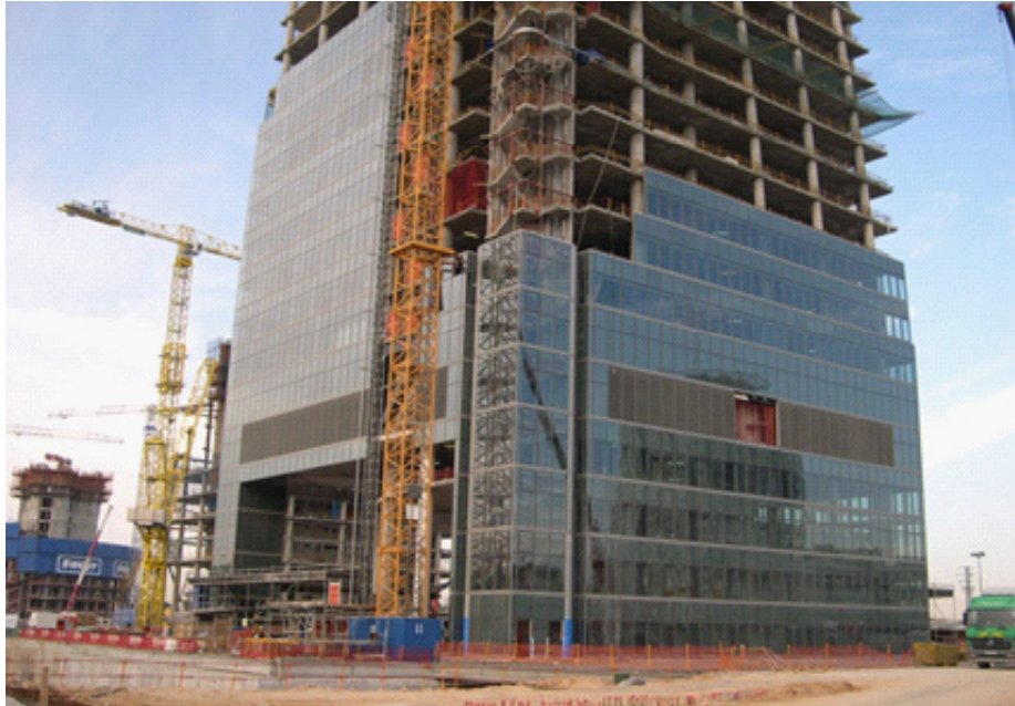
Figura 60: Torre Espacio (Madrid). Soluciones planteadas en este capítulo fueron usadas durante su construcción.
