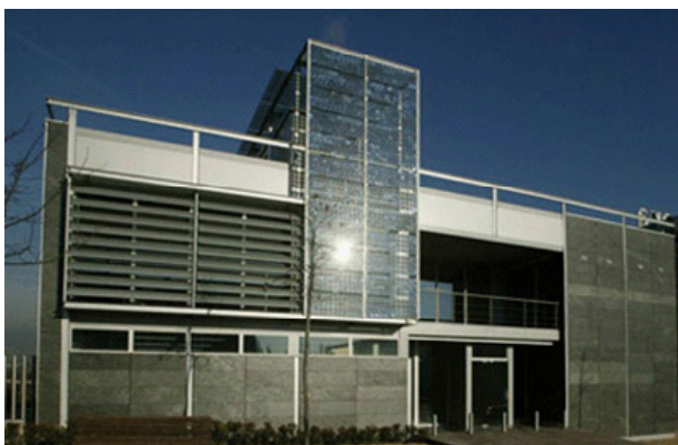
Figura 96: Sistema de lamas con control automático en la fachada del Edificio Ecobox – Fundación Metrópoli de Madrid. Fuente: Colegio Oficial de Arquitectos de Málaga.
