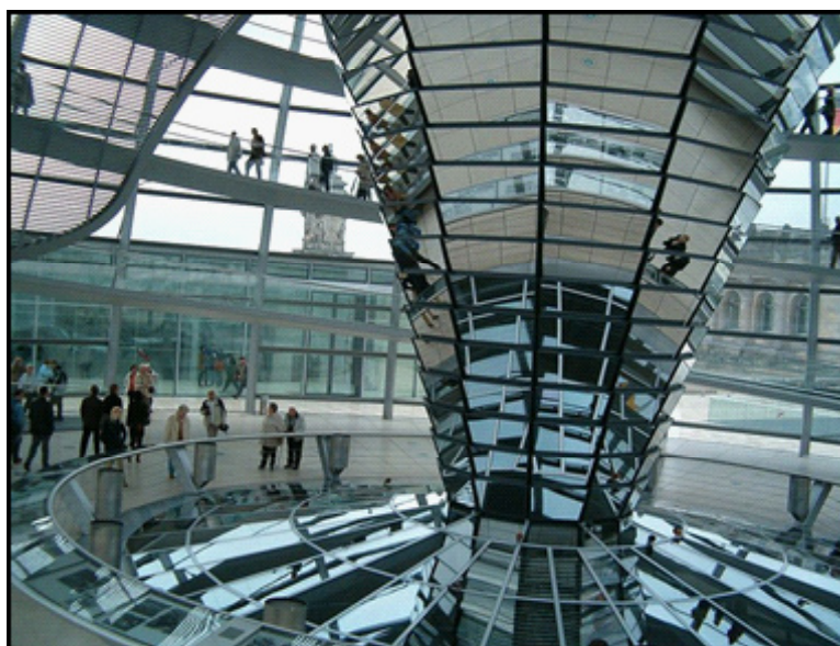
Figura 97: Sistema de espejos que permite introducir luz natural al interior del Reichstag en Berlín.
