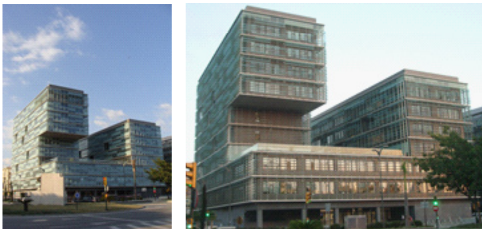
Figura 95: Sistema automatizado de lamas en la fachada de la Gerencia Municipal de Urbanismo de Málaga.
