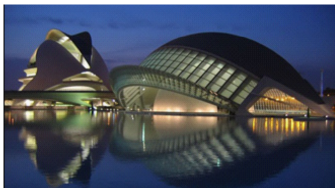
Figura 98: Control de la iluminación exterior en la Ciudad de las Artes y las Ciencias de Valencia.
