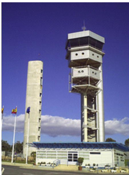
Figura 103: Torre de control del aeropuerto de Alicante.
