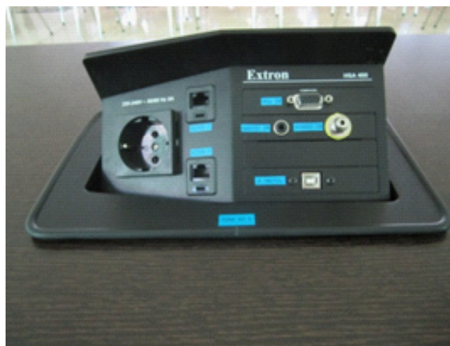
Figura 44: Caja de conexiones multimedia.
