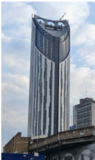
Figura 93: Aerogeneradores en edificio de uso residencial (Edificio La Strata, Londres).
