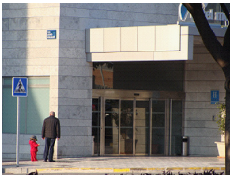
Figura 100: Control de presencia para apertura automática de puertas en el Hotel Monte Málaga de Málaga.
