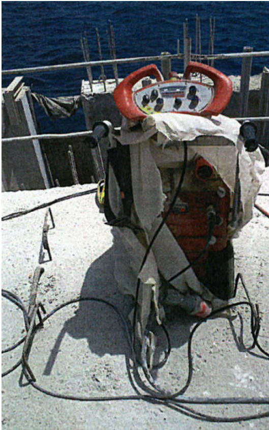
Imagen 5. Mando de la máquina cortamuros y su situación desde donde se manejaba con visión de la zona de trabajo.
