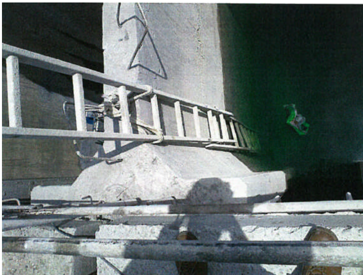
Imagen 6. Escaleras manuales utilizadas para acceder al fondo del cajón y cambiar los raíles de corte del cabezal, cambiar discos, etc. La profundidad del lugar a acceder supera los 6 metros.
