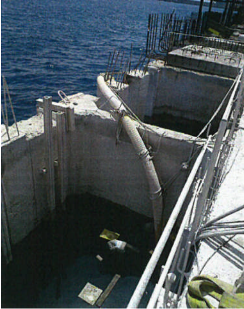
Imagen 1. Vista de los casetones. Se puede ver uno con las ventanas realizadas y otro con la tapa de hormigón ya colocada.
