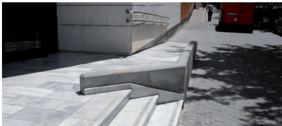
Acceso mediante rampa.
