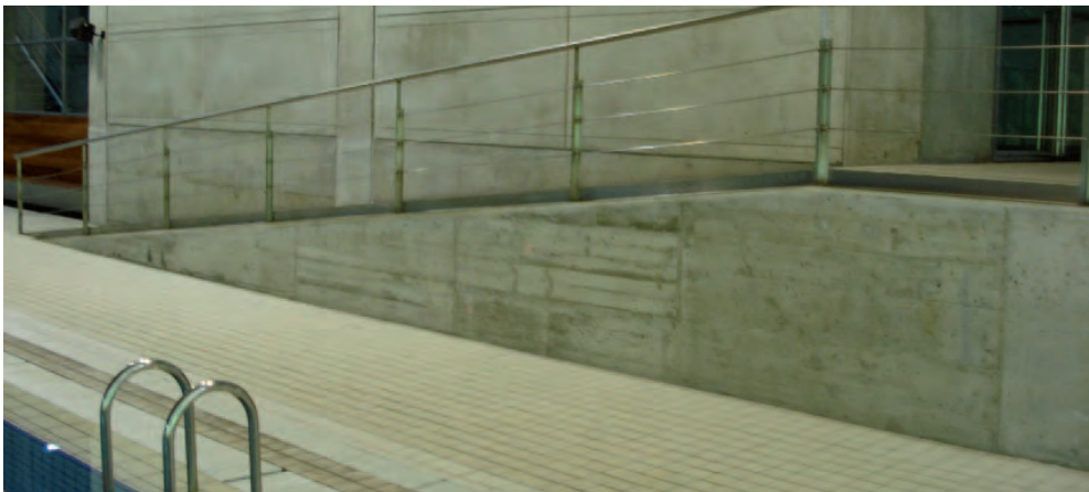
Acceso mediante rampa.
