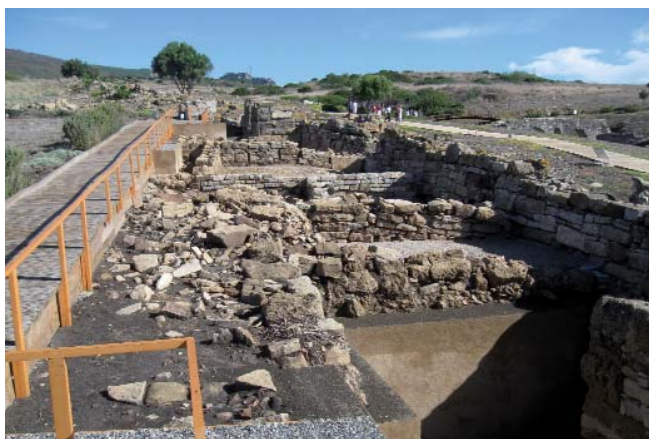
Muralla sureste de Baelo Claudia . Intramuros. Aspecto una vez realizadas labores de consolidación de perfiles y estructuras arqueológicas.
