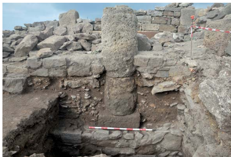
Fig. 13. Sondeo practicado en la Calle de las Columnas con el detalle de la cimentación del pórtico.
