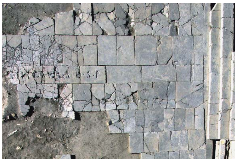
Fig. 18. Tramo final de la inscripción junto a la escalera del templo.
