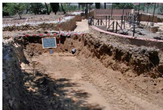
Trabajos de eliminación de los parterres-jardineras conformados durante las excavaciones de Fernández López y Bonsor.
