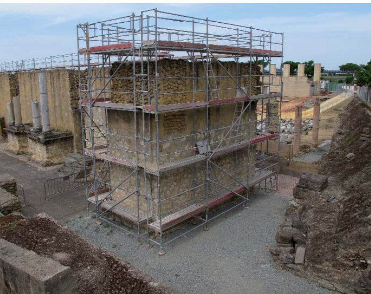
El Teatro Romano de Itálica en obras.
