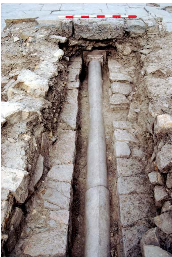
Fig. 8. Tubería de plomo colocada en la cloaca del cardo.
