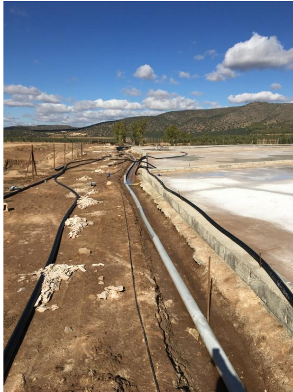
Vista de las incrustaciones y tubería ya reparada para su enterramiento.
