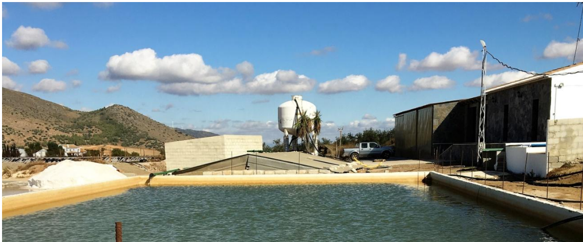
Vista de la piscina de disolución cubierta y depósito de carga por gravedad
