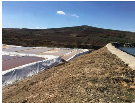
Vista del desnivel existente entre la balsa nº 1 y el circuito provisional de exposición plastificado sobre el suelo natural
