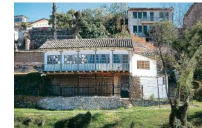
El inmueble se levanta y se apoya sobre muros de contención realizados en piedra de canto de río, en donde se empotran columnas de madera que forman pórticos para la sustentación del nivel superior.
