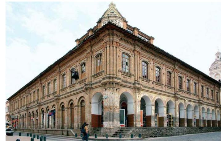
En planta baja, las puertas son de madera, enmarcadas por dos arcos de medio punto; en planta alta, las ventanas de arco rebajado están enmarcadas con molduras fileteadas, cada alféizar está decorado geométricamente, y los sobredinteles se apoyan sobre pilastrillas con decoraciones de conchas que se enlanzan a los alfeizares cerrando una bella composición.
