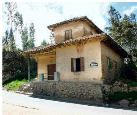
Esta pequeña villa rural, a las afueras de la ciudad, se levanta sobre un ancho zócalo de piedra de canto rodado. Su conformación espacial, así como la tecnología utilizada, son muy propias de nuestro medio. Gruesos muros de adobe, estructura de madera y cubierta de teja. Su portal exterior se abre hacia la avenida Loja, con una pequeña escalera de acceso para sortear el desnivel en el que se ubica el inmueble con respecto a la calzada.
