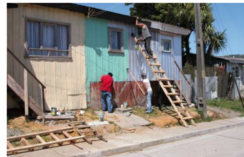
Obras de rehabilitación en la Población Ramón Freire, Ancud
