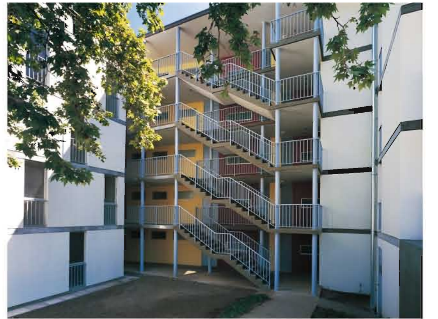
Escaleras de acceso desde el frente poniente
