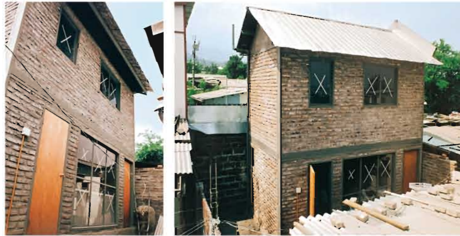
Construcción de viviendas en el fondo de patio de las viviendas existentes
