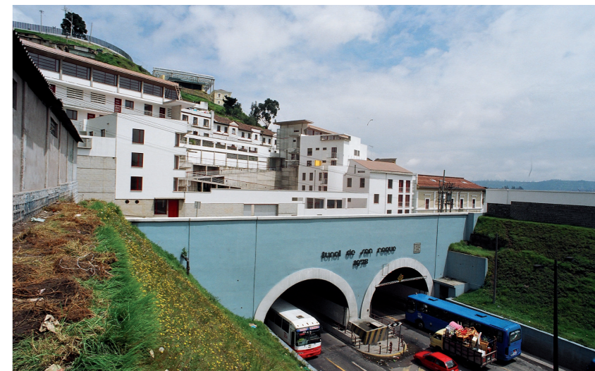
Vista del Túnel de San Roque bajo El Penalillo
