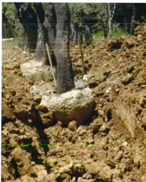
19. Apertura de zanja para aviveramiento.
