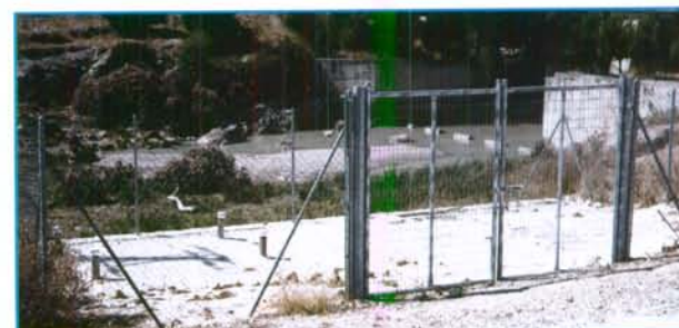
Vista general de la EDAR de Puente de la Cerrada.
