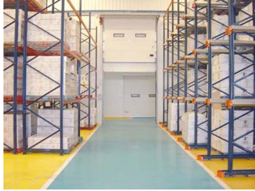
Foto 5: Almacén de producto terminado
