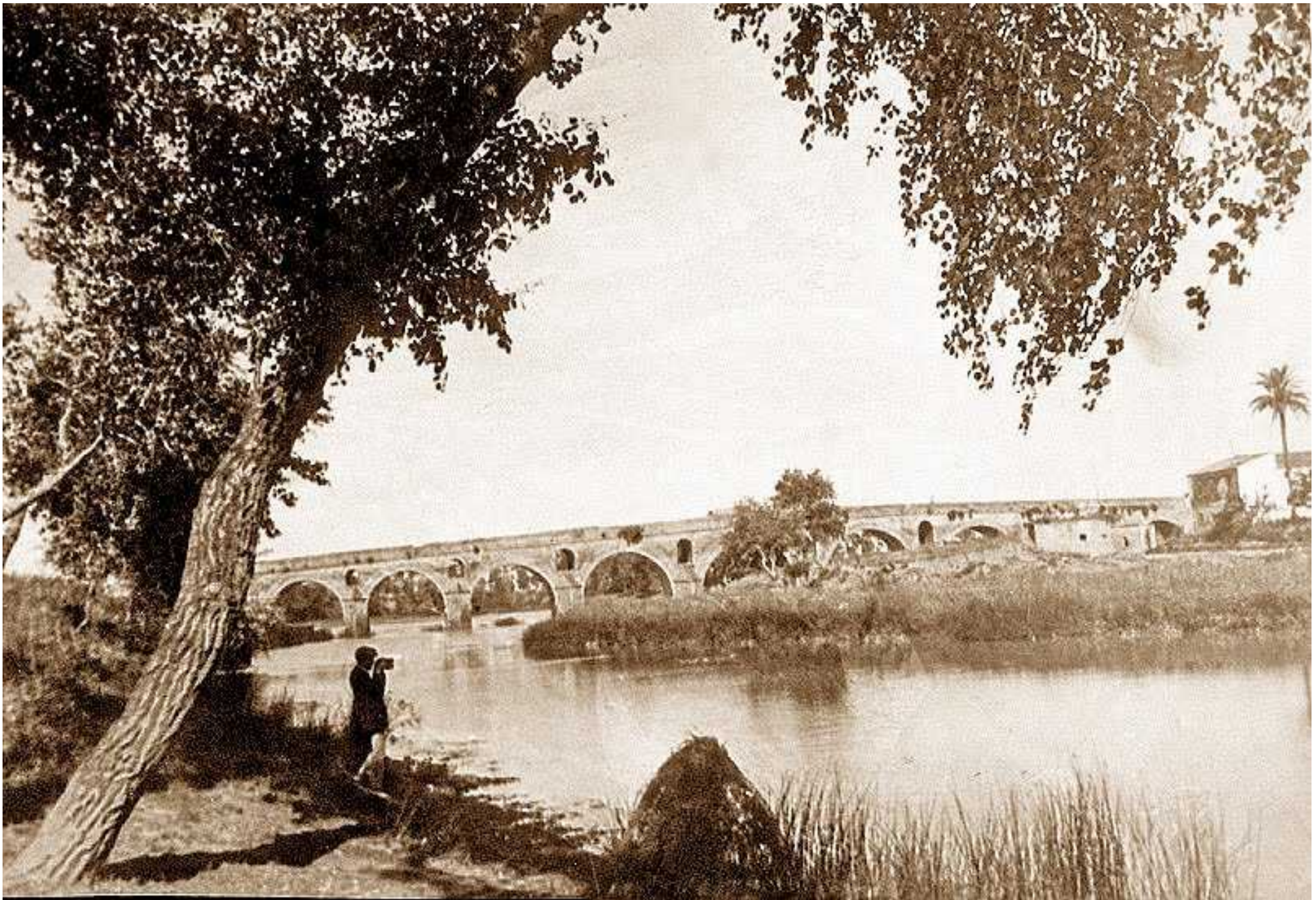
El Guadalete a su paso por el puente de Cartuja (1917).
