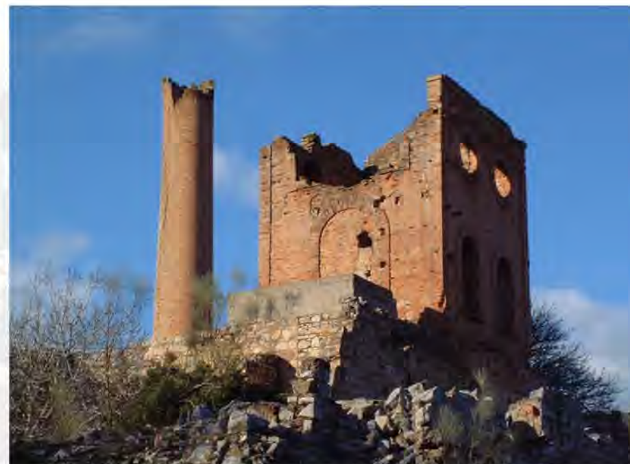
Restos de la infraestructura minera de San Pascual, Linares. Carlos Feixas.
