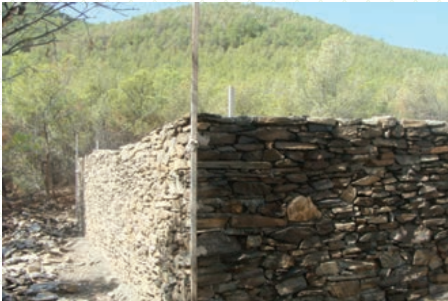
Ejecución de las obras de adecuación de la instalación de "El Entredicho".
