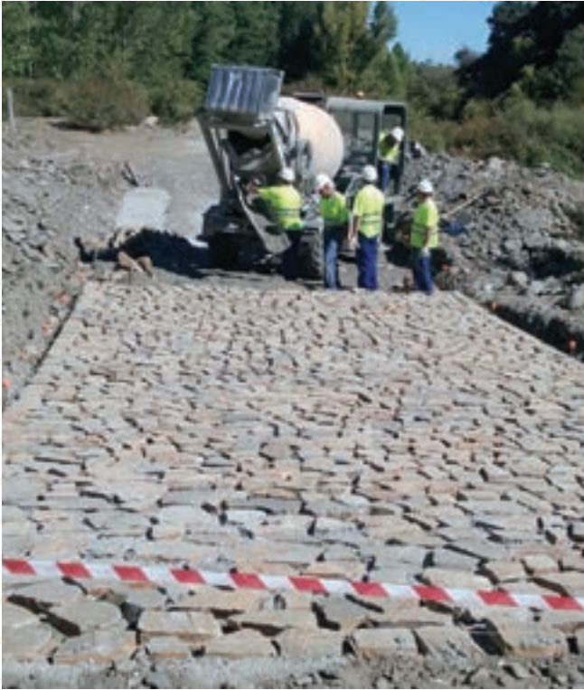
Construcción de badén de piedra.
