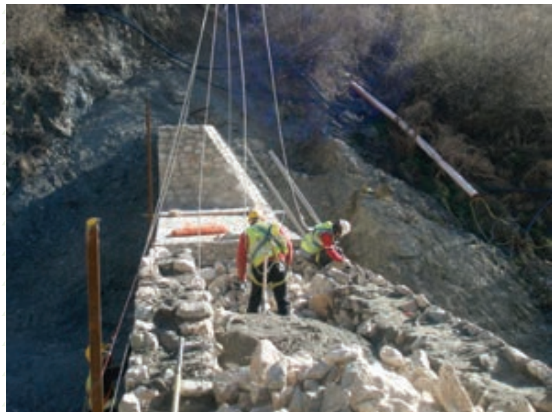
Ejecución de dique en Trevélez
