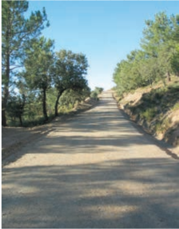
Estado del camino en el monte "Los Jarales" del T.M. de Cañar tras la ejecución de las obras.
