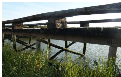
• Detalle de pasarela de madera.
