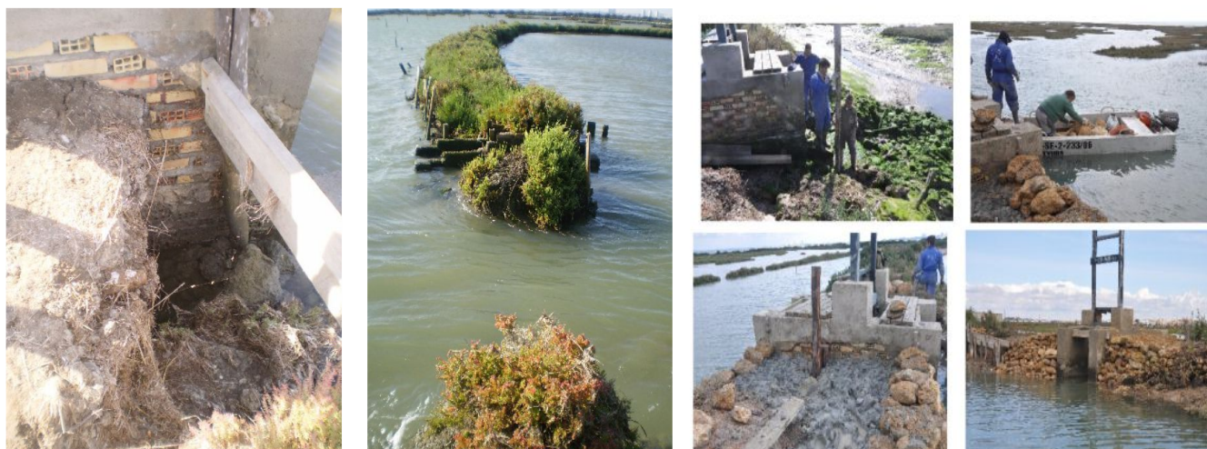
• Trabajos de restauración en la salina La Covacha (Foto: Antonio Gómez).
