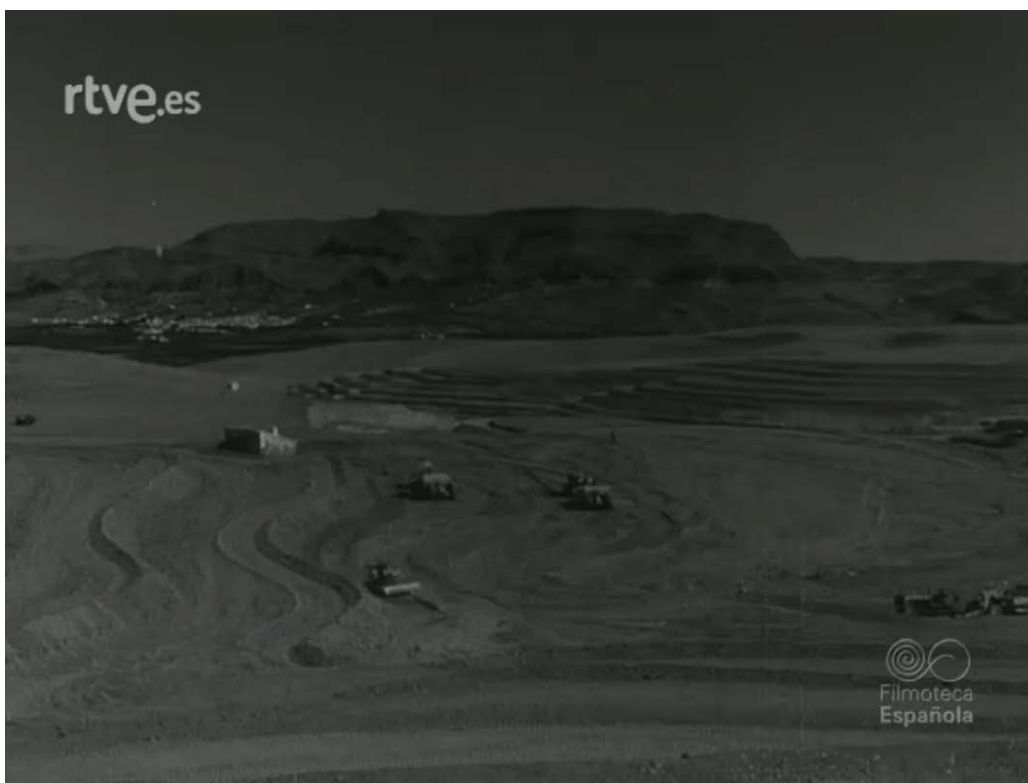
NO-DO 982C, La zona malagueña de Pizarra se transforma. Construcción de canales y acequias de regadío , 30-10-1961.
