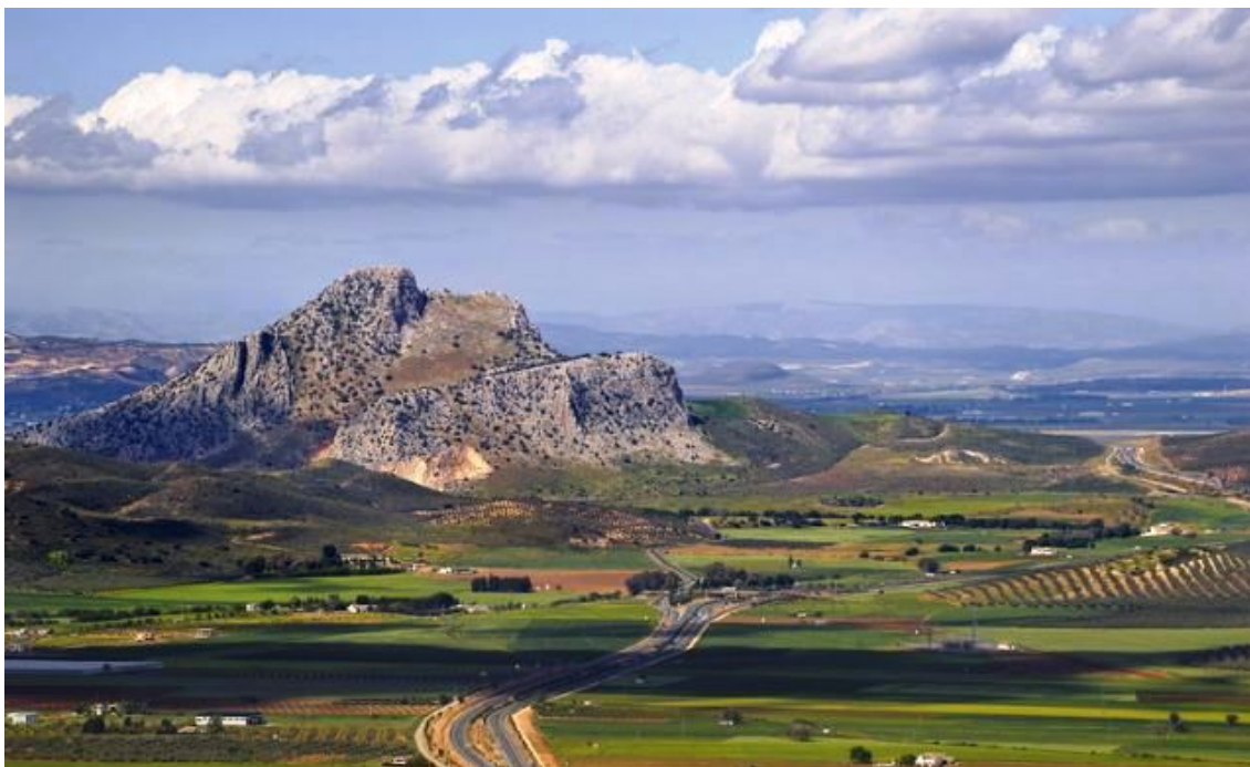
Autovía A-92 a su paso por Antequera.
