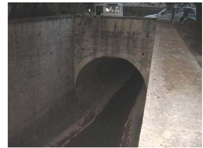
Túnel del Trasvase del Cubillas boca 2.
