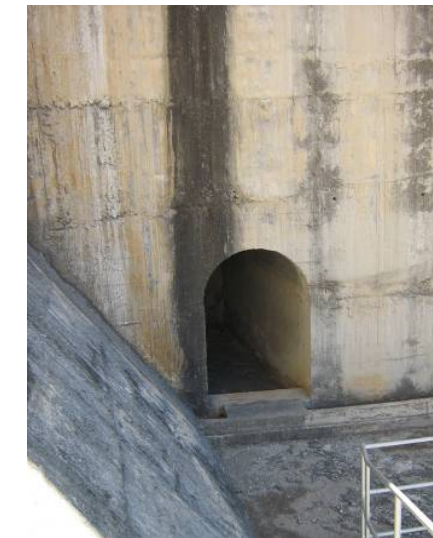
Entrada a las galerías inferiores de la presa.
