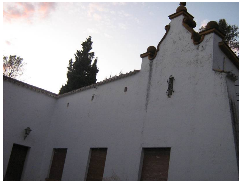
Casa del Ingeniero de la Central Eléctrica del Pintado.
