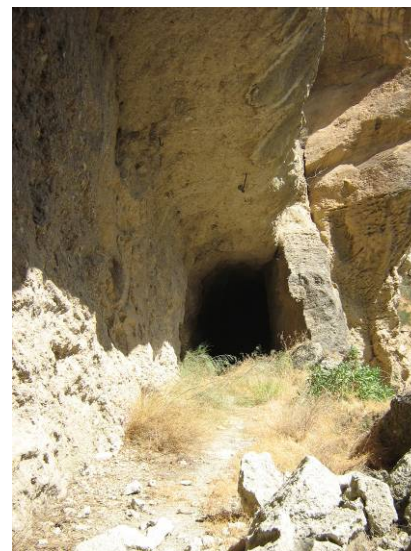
Túnel I del Tranvía de la Sierra
