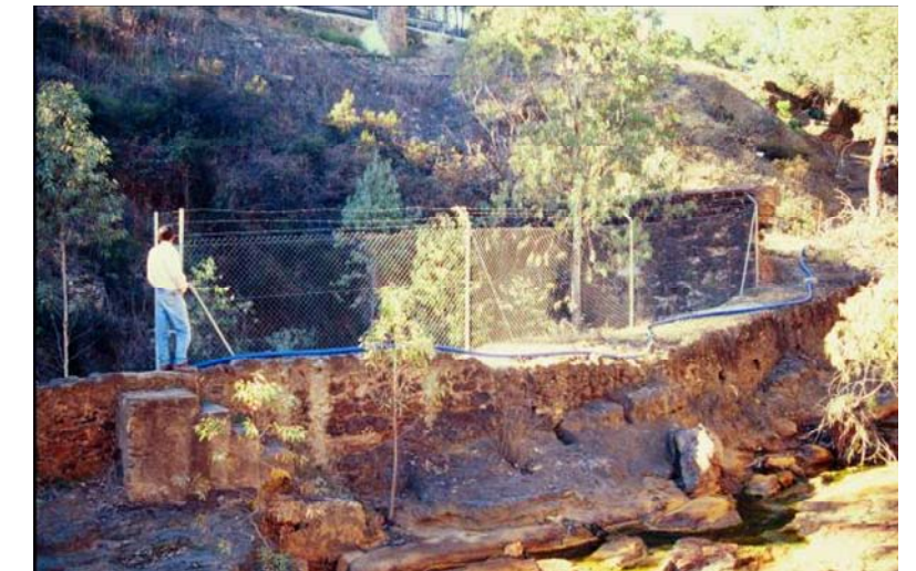
Bombeo de aguas ácidas, procedentes de la galería de desagües, a la depuradora ubicada en las instalaciones superiores de la mina.
