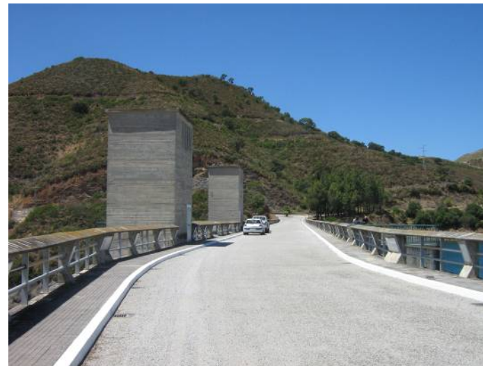
Presa de la Concepción. Entrada desde la parte superior a las galerías de mantenimiento.
