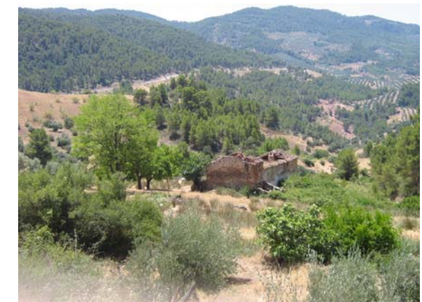
Vista general de la casa de la Salina Vieja, donde se puede apreciar el techo totalmente hundido.
