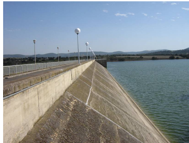
Presa Sierra Boyera (Córdoba)
