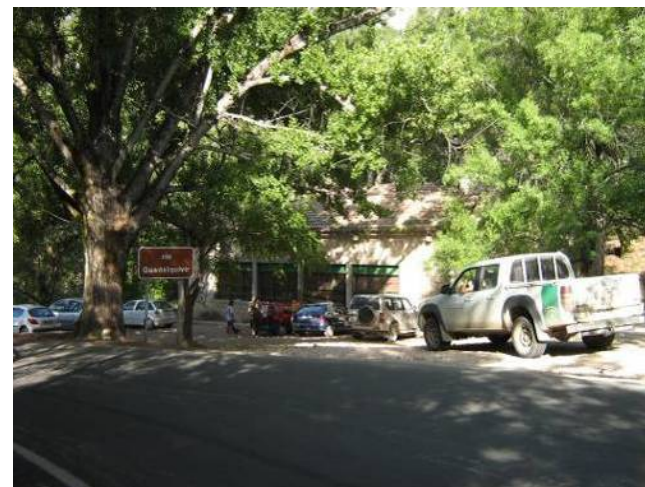
Central Eléctrica Cerrada de Utrera.
