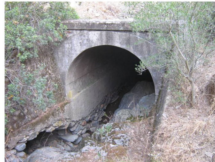
Túnel del Viar II.
