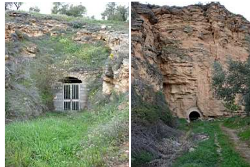
Túnel de la Huertas II (boca 1 y boca 2).
