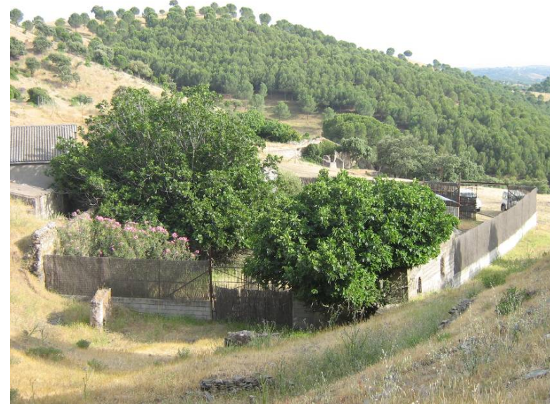
Edificio del complejo minero Huertas Bajas o de Chaparrera.
