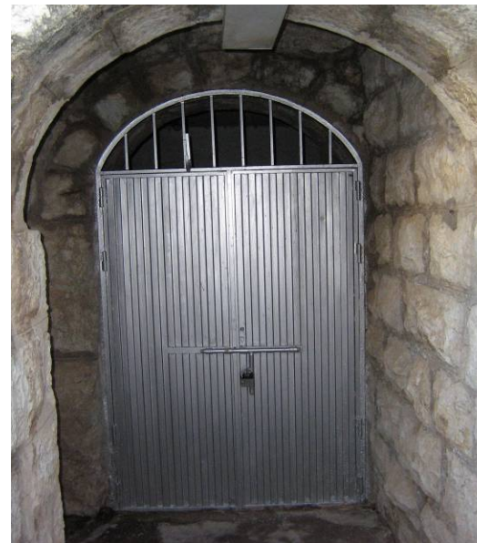
Almacén de la Presa del Conde Guadalhorce.
