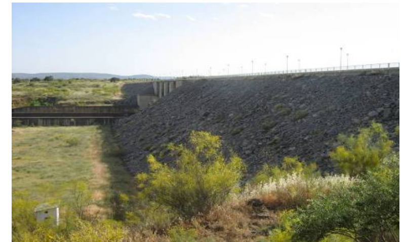
Entrada principal a las galerías de mantenimiento de la Presa Boyera.
