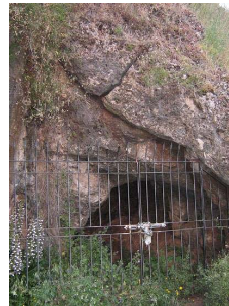
Cerramientos apropiado para el paso de los murciélagos como medida de regulación del acceso a los refugios con colonias de la especie.
