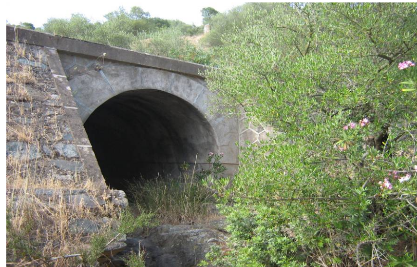
Túnel del Viar I
