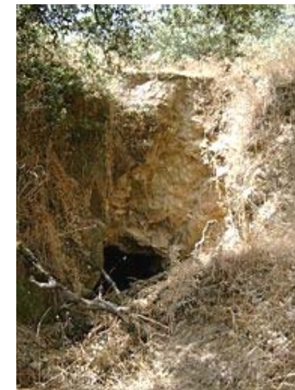
Entrada a la galería de la mina El Coto cegada, casi en su totalidad, con escombros de la ladera (foto derecha).
