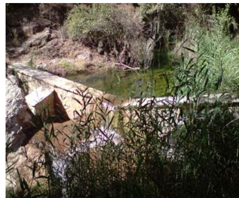
Fotografía de uno de los diques
