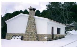
Ctra. Cruce del Valle- Puente de las Herrerías km 7 Vadillo Castril, Jaén Teléfono: 953 124 235
