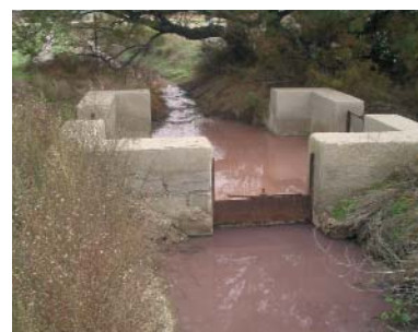
Canal periférico para la captación de vertidos de aguas residuales con carga orgánica (Otoño 2003)
