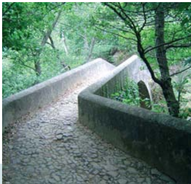
Puente sobre el Río de la Miel Pont sur le Río de la Miel
