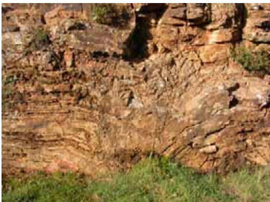
FOTO 81. Detalle de la estructura de colapso.
