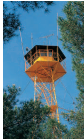
TORRE METÁLICA DE VIGILANCIA.
