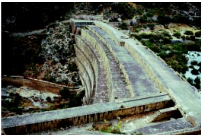
Detalle. Aliviadero y presa.
