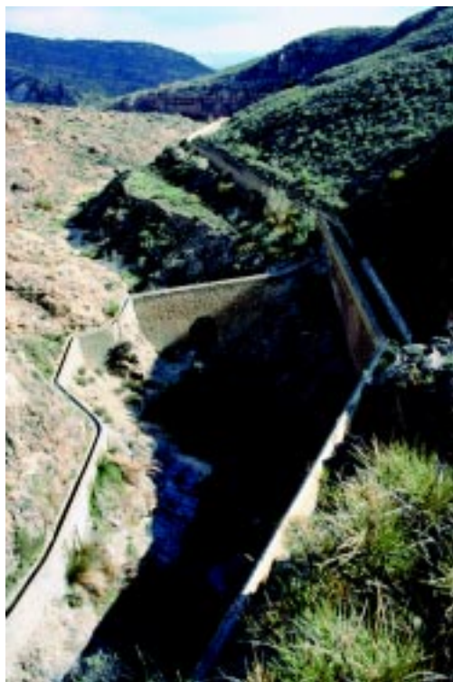
Canalización de salida.
